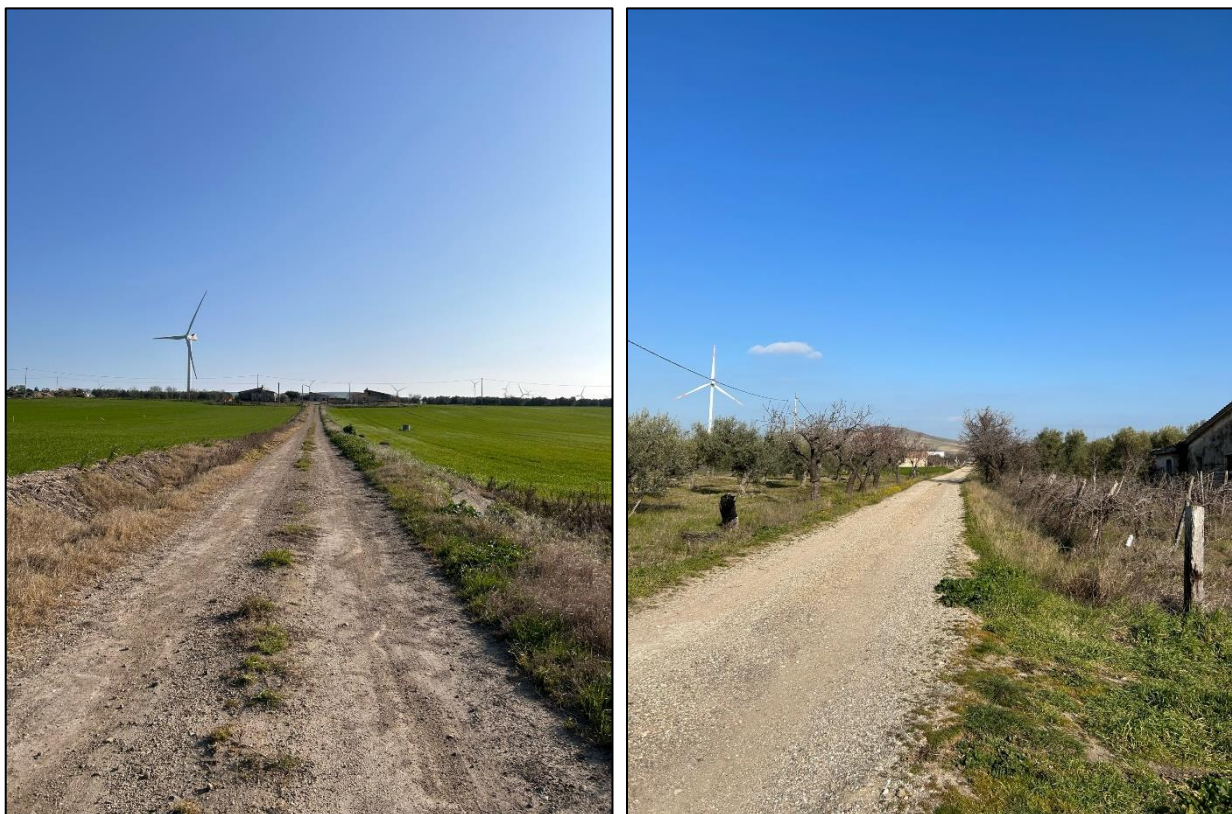
Figura 49 – 50: Viabilità percorsa dal cavidotto
