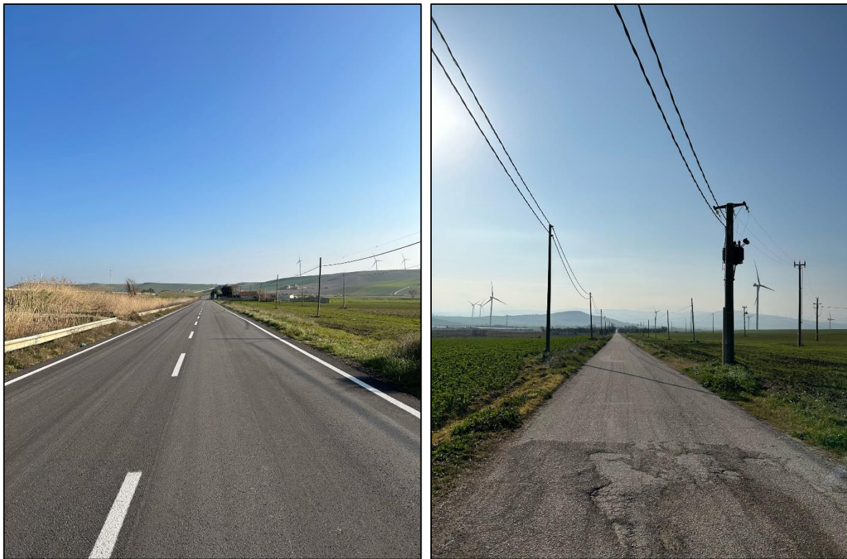
Figura 47 – 48: Viabilità percorsa dal cavidotto
