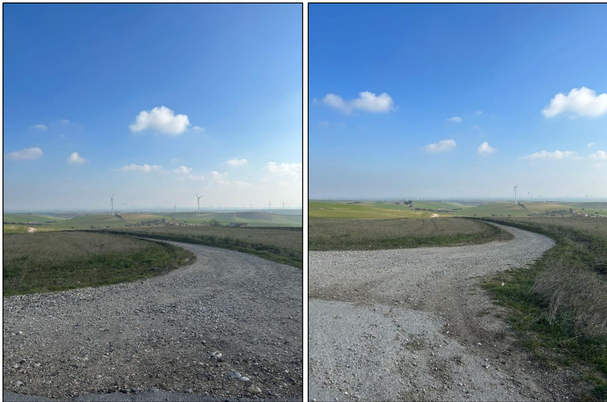
Figura 51 – 52: Viabilità percorsa dal cavidotto
