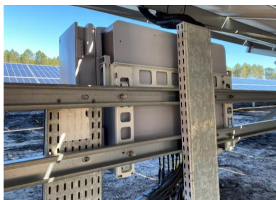
Figura 7: Supporto per quadri elettrici
