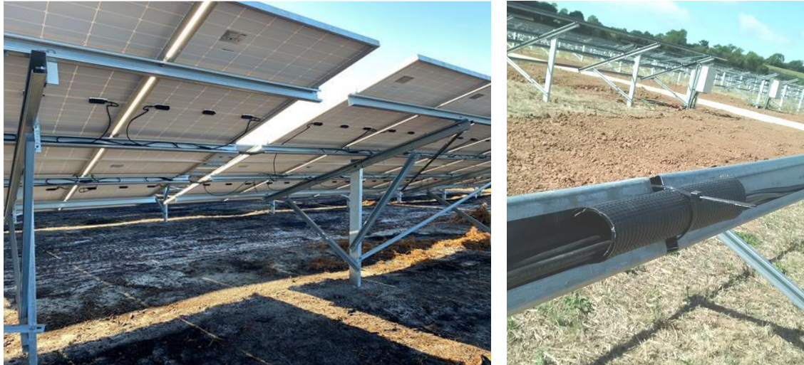
Figura 3: Cablaggio stringhe
