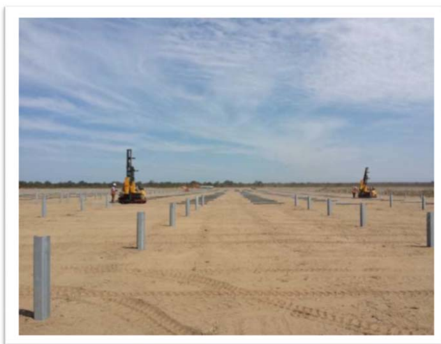
Figura 12 – Foto esempio di Impianti realizzati con stessa struttura e stessi moduli fotovoltaici.
