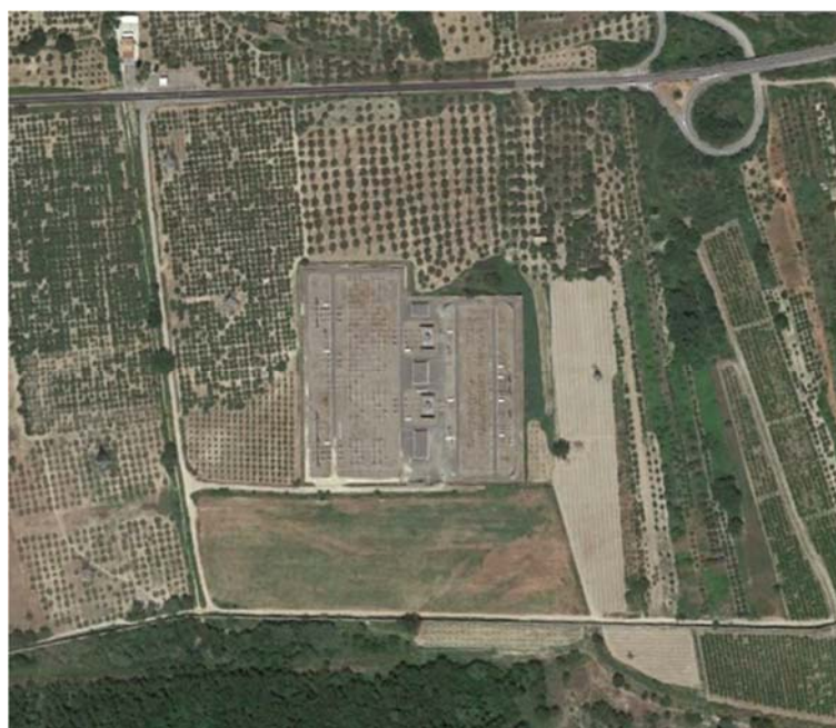
Figura 10 –S.E Terna Esistente 150 kV Aliano
