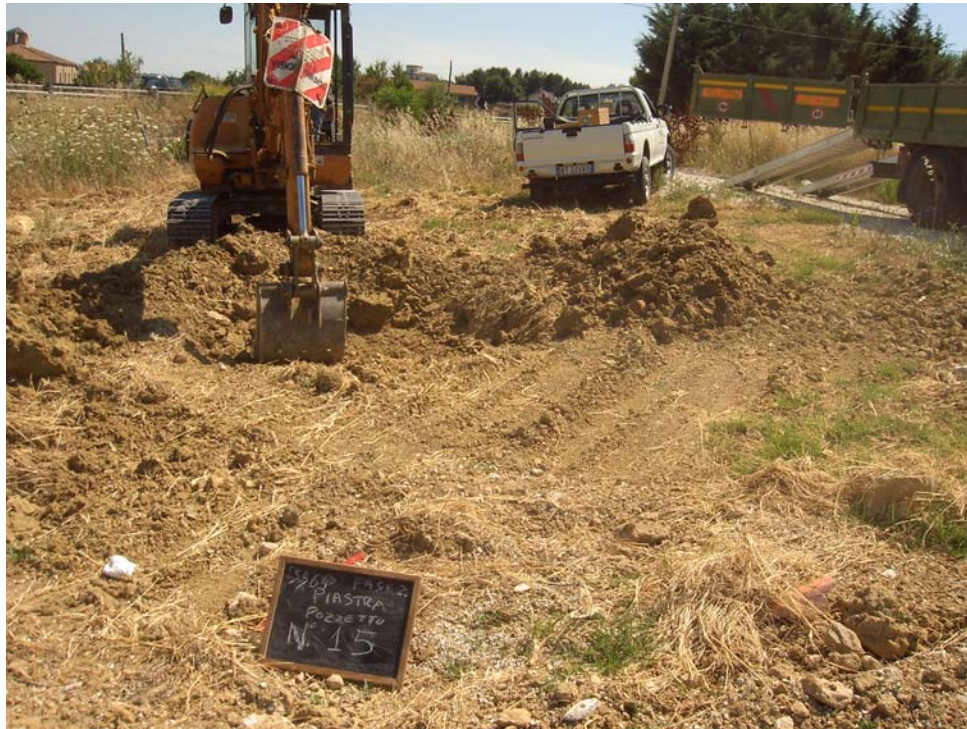
Prova di carico su piastra - pozzetto 15
