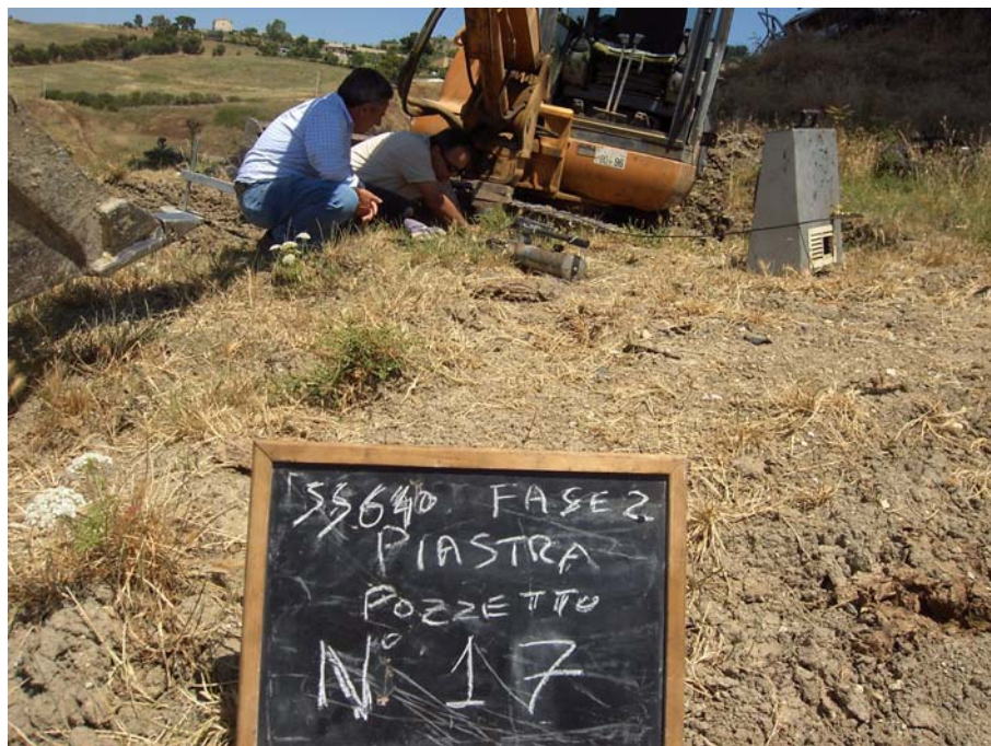
Prova di carico su piastra - pozzetto 17
