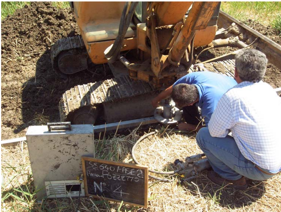
Prova di carico su piastra - pozzetto 4
