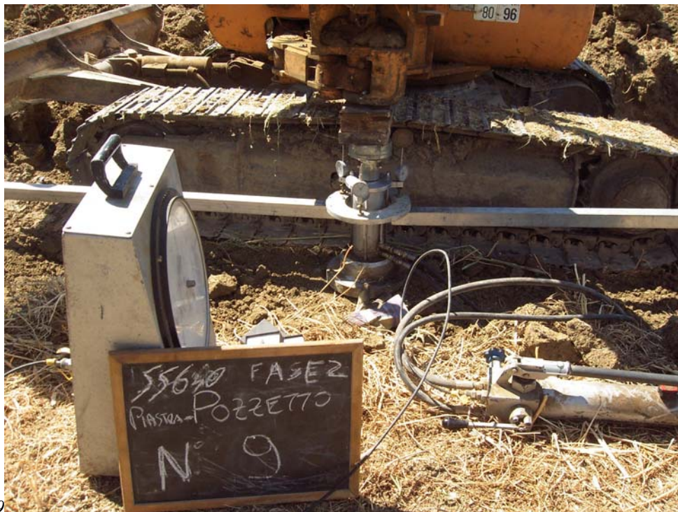
Prova di carico su piastra - pozzetto 9
