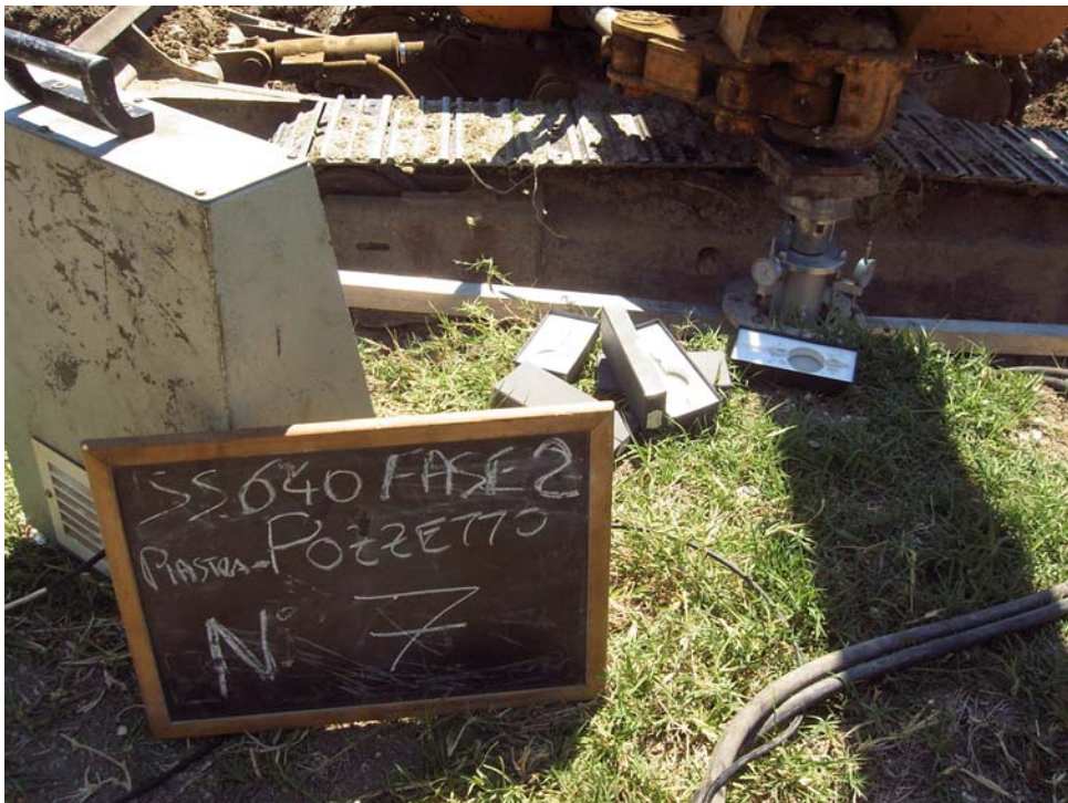
Prova di carico su piastra - pozzetto 7
