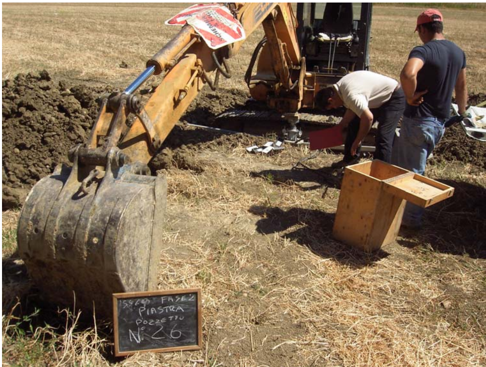
Prova di carico su piastra - pozzetto 26
