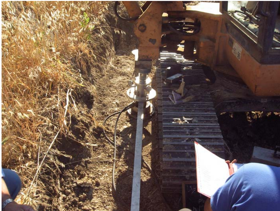
Prova di carico su piastra - pozzetto 12
