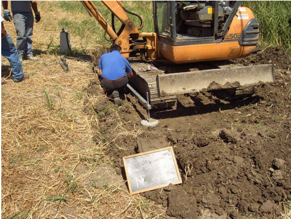
Postazione prova di carico su piastra - pozzetto 4
