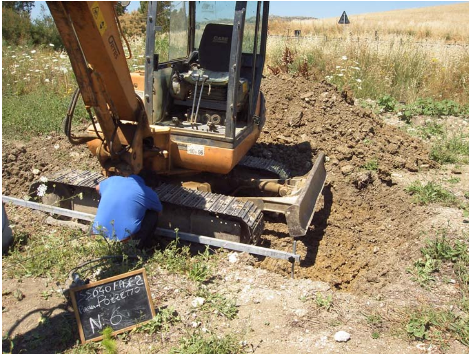
Prova di carico su piastra - pozzetto 6
