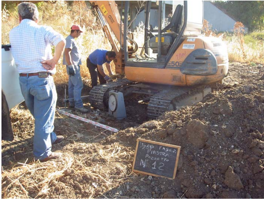
Prova di carico su piastra - pozzetto 12
