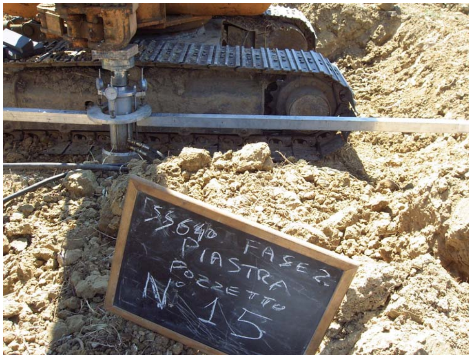
Prova di carico su piastra - pozzetto 15
