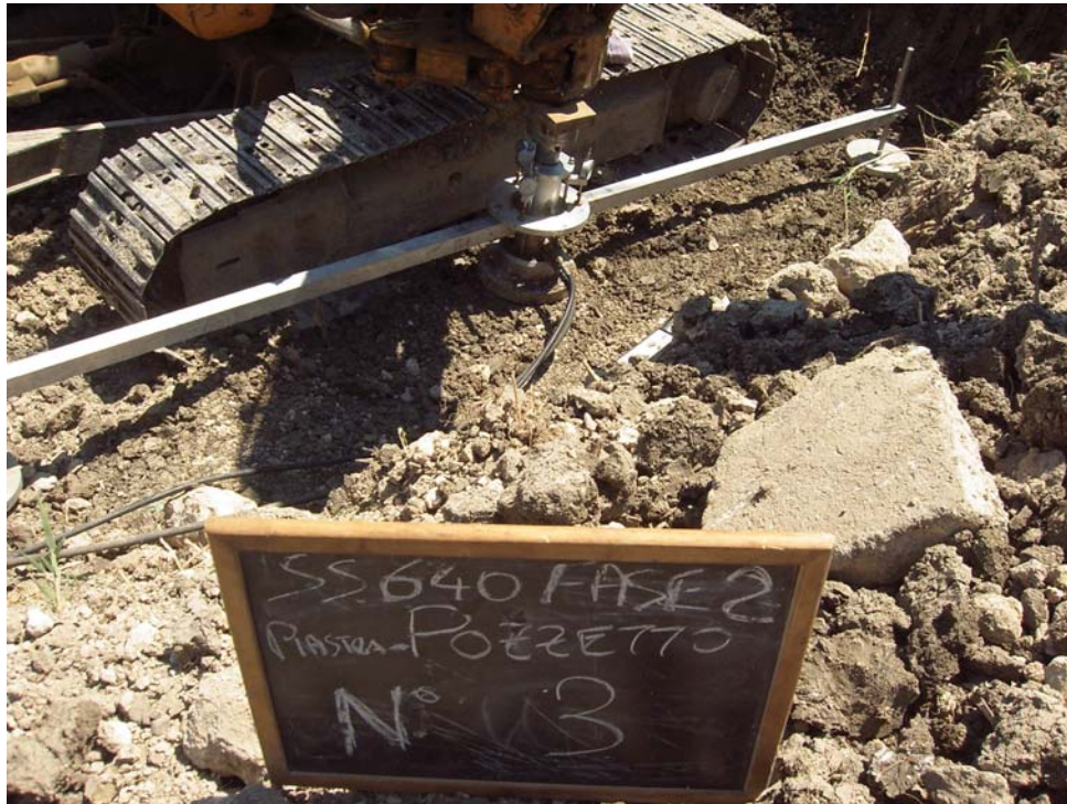
Prova di carico su piastra - pozzetto 3
