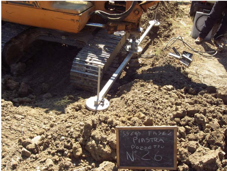
Prova di carico su piastra - pozzetto 26
