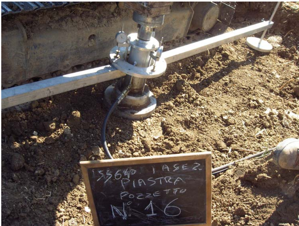
Prova di carico su piastra - pozzetto 16
