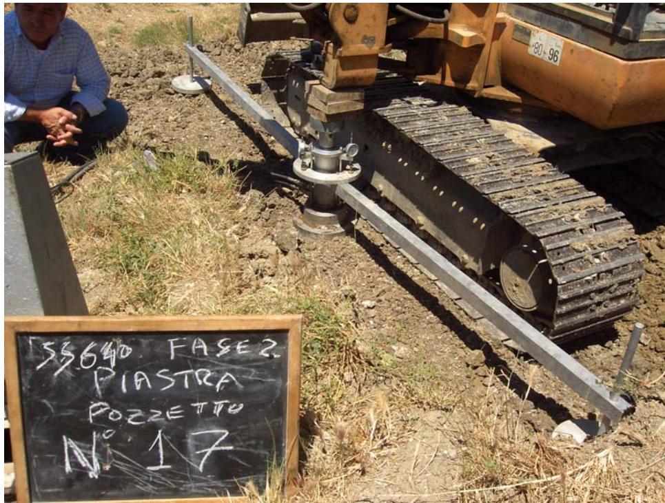
Prova di carico su piastra - pozzetto 17
