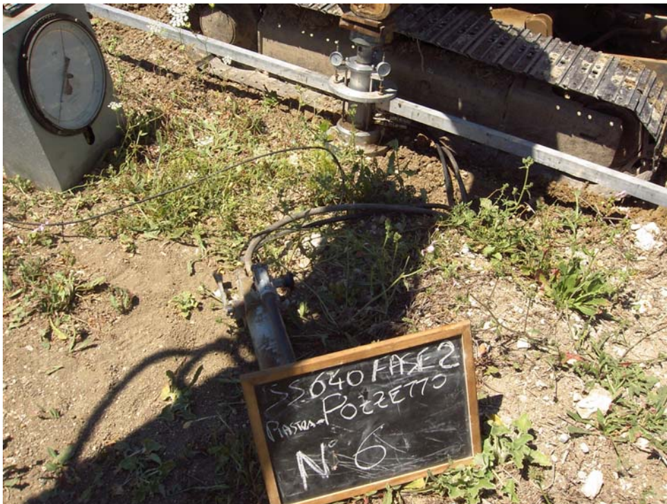
Prova di carico su piastra - pozzetto 6
