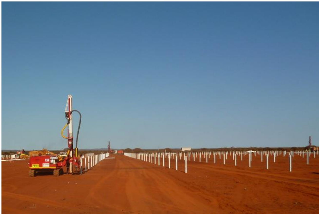
Figura 53: Infissione sostegno a mezzo di battipalo
