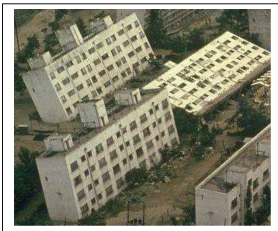
Fig. 16 - Effetti della liquefazione del terreno a seguito di un terremoto.
