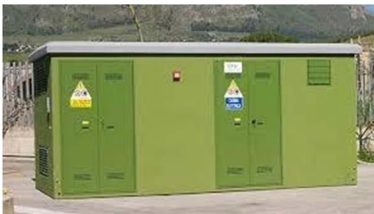
Figura 7 - Cabina prefabbricata tipica utilizzata in progetto
