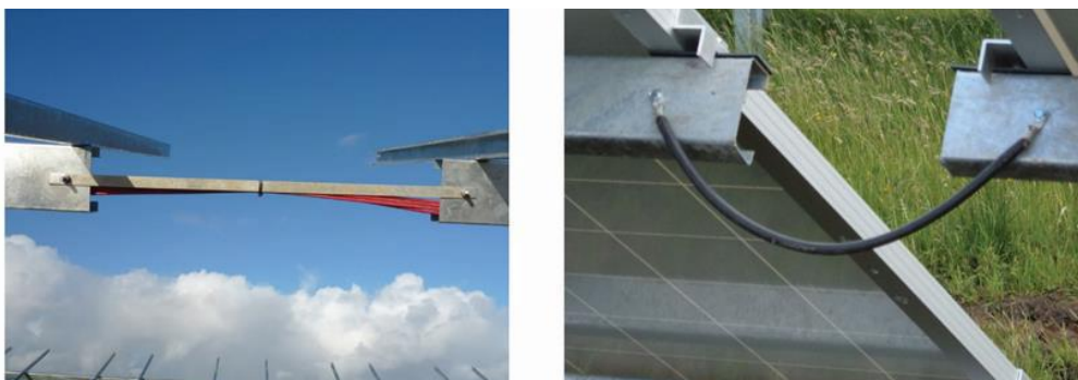
Figura 6: Collegamento equipotenziale tra strutture adiacenti
