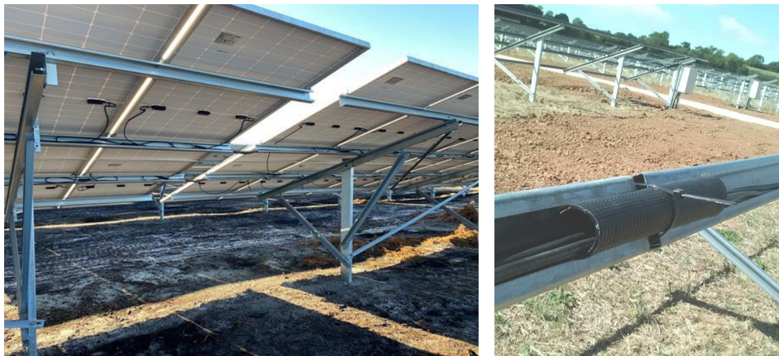
Figura 3: Cablaggio stringhe
