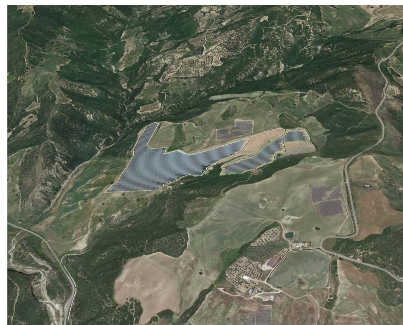
FOTOINERIMENTO DALL'ALTO - VISTA DA SUD AREA D'IMPIANTO POST OPERAM
