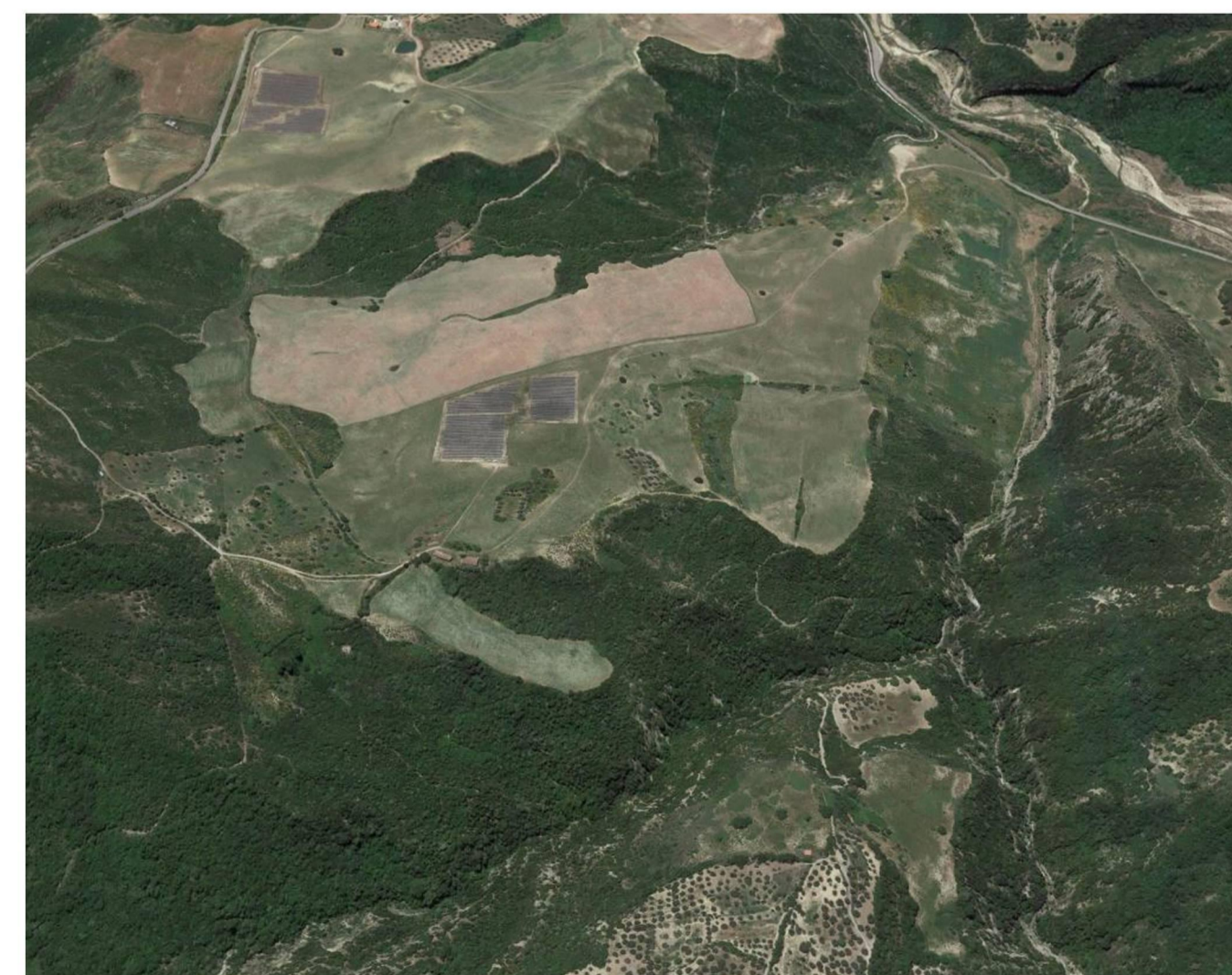
FOTOINERIMENTO DALL'ALTO - VISTA DA NORD AREA D'IMPIANTO ANTE OPERAM
