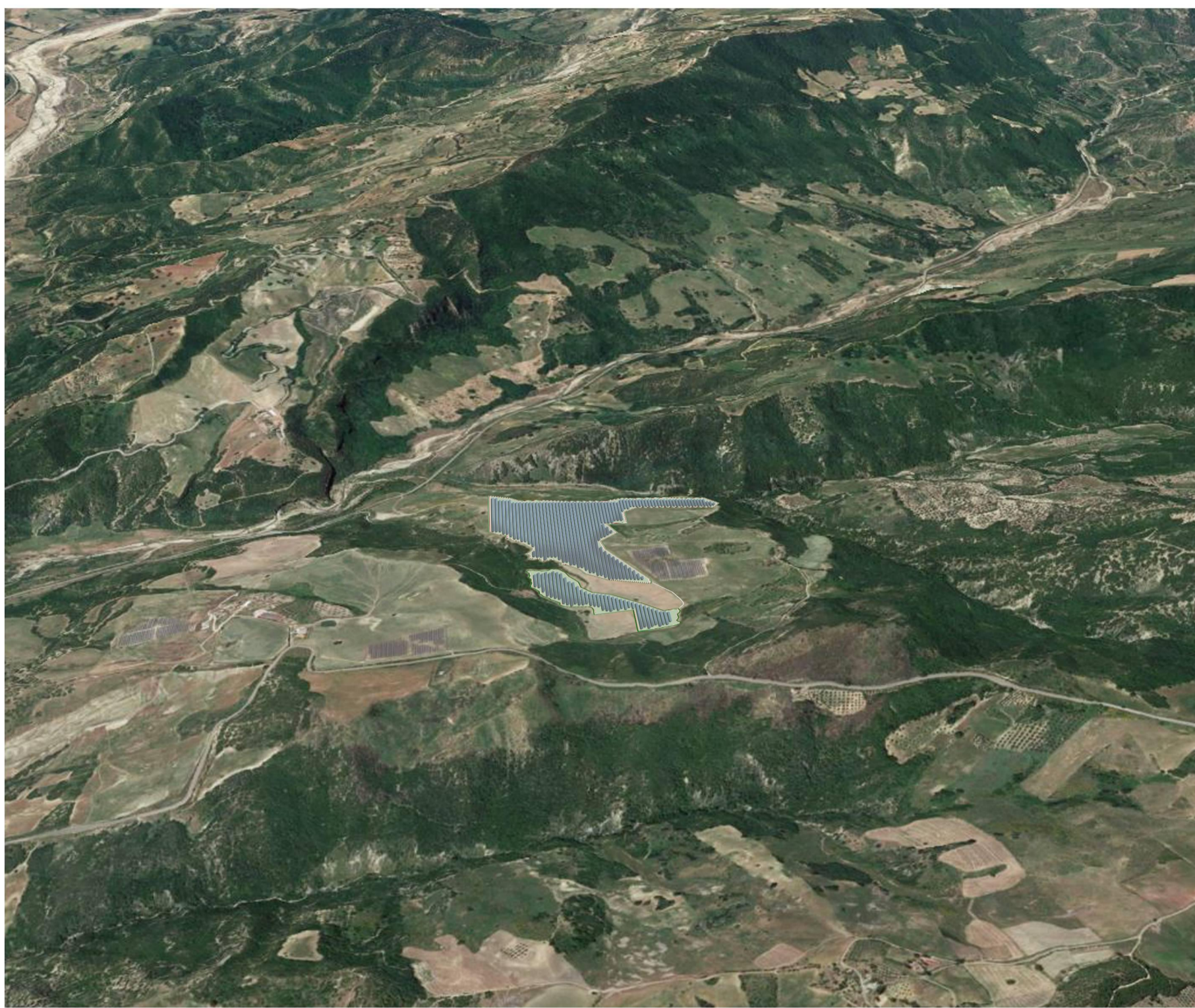
FOTOINERIMENTO DALL'ALTO - VISTA DA EST AREA D'IMPIANTO POST OPERAM
