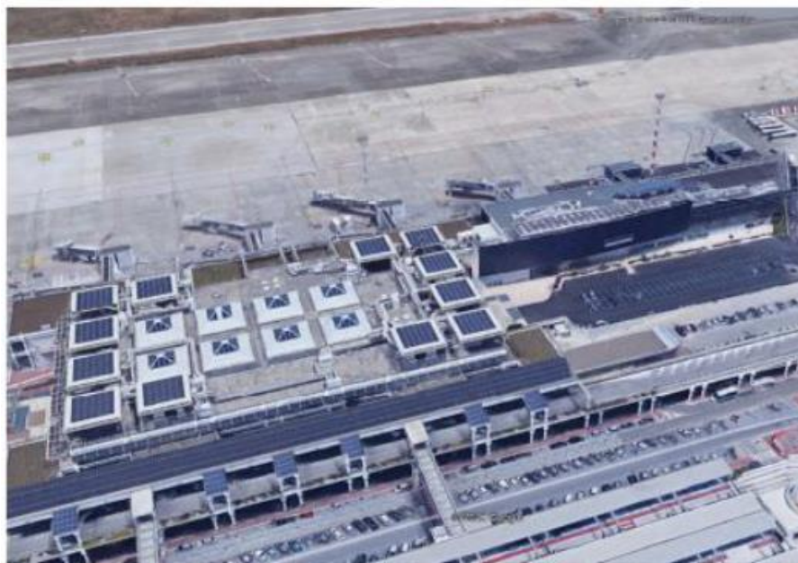
Figura 59 - Esempio di un fotovoltaico installato all'interno di un aeroporto
