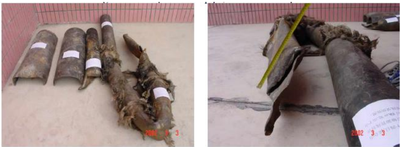
Fig. 26 - Danni subiti dalla condotta durante il terremoto del 2001 vicino a Qinghai-Xinjiang, Cina.
