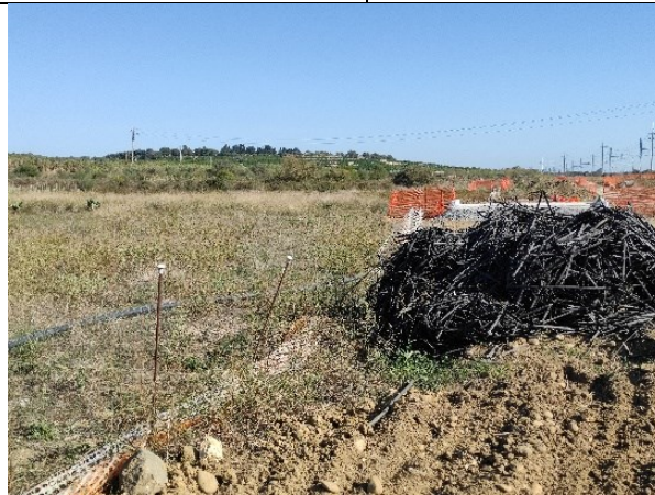
UR 12 – Particolare dell'area interessata dai lavori lungo il margine meridionale
