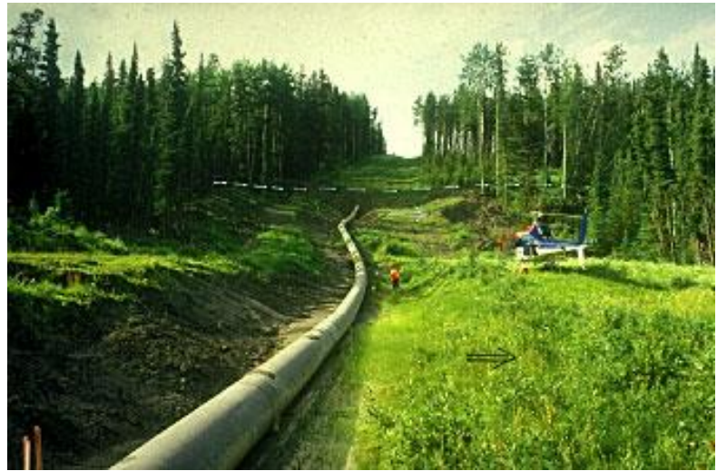
Fig. 12 - A sinistra il modello illustra l'interazione tra una frana ed una condotta disposta perpendicolarmente alla direzione di movimento della frana (Treccani). A destra: un oleodotto che si è spostato lateralmente di 9,5 m a causa di una frana.
