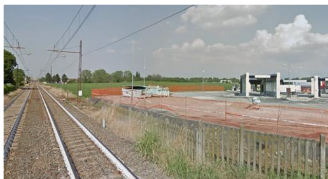
FIGURA 12 - VISTA 8 INCROCIO FERROVIA- VIA CASALCERMELLI
