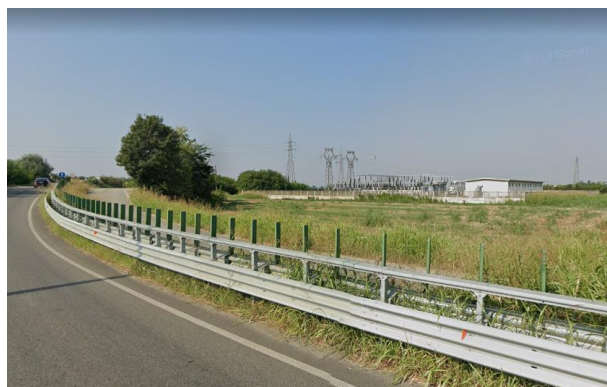
FIGURA 14 - VISTA 10 SP 185 - CABINA DI CONSEGNA
