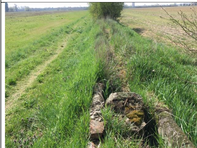
FIGURA 39 - FOTO DEL CANALE (IN PARTE INTERRATO)
