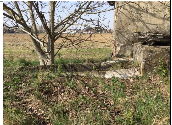
FIGURA 38 - FOTO DEL POZZO
