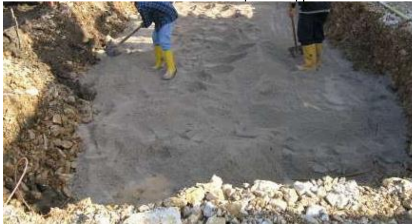
FIGURA 12 - SBANCAMENTO PIANO POSA CABINE
