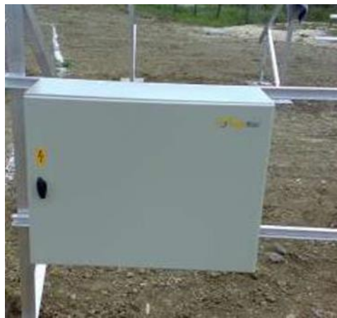
FIGURA 1 - QUADRI IN PARALLELO
