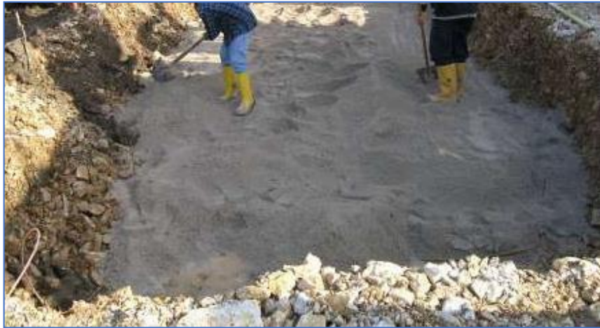
FIGURA 6 - SBANCAMENTO PIANO POSA CABINE
