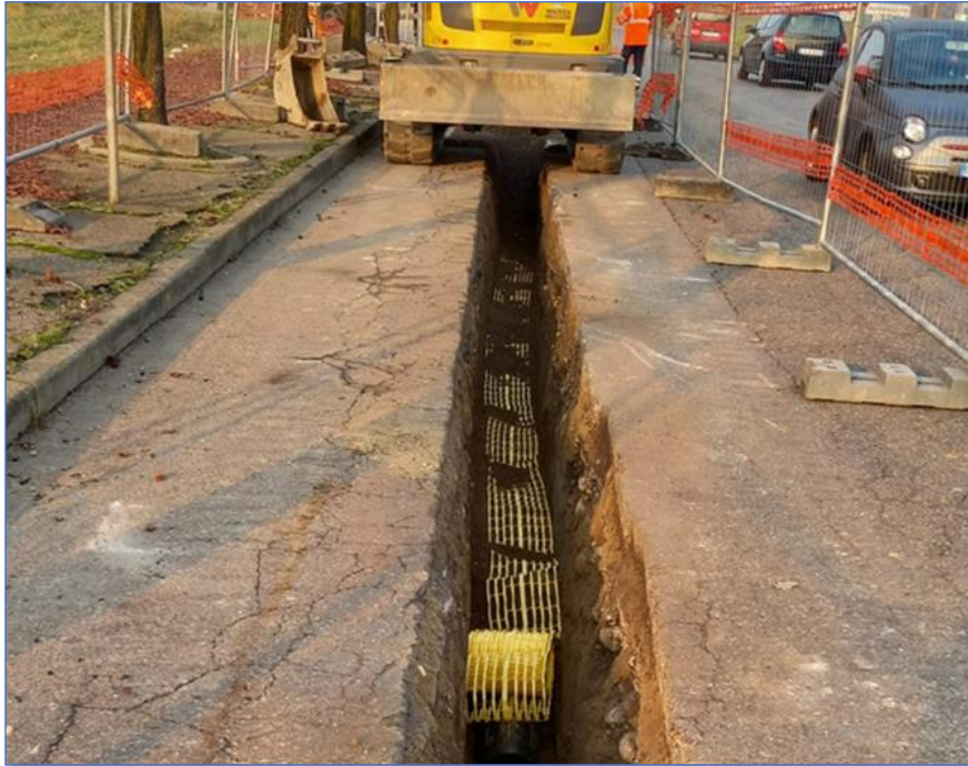
FIGURA 11- SCAVI STRADALI PER POSA CAVIDOTTO
