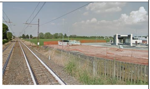
FIGURA 11 - VISTA 8 INCROCIO FERROVIA- VIA CASALCERMELLI
