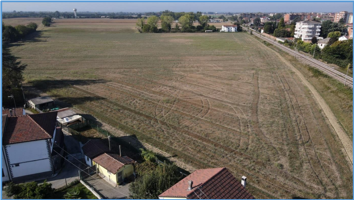
FIGURA 106 VISTA AEREA DELL'AREA DI PROGETTO - STATO DI FATTO (VISTA AEREA)
