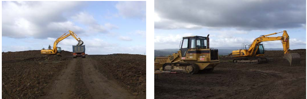
Fig. 32 – Operazioni di realizzazione piazzole
