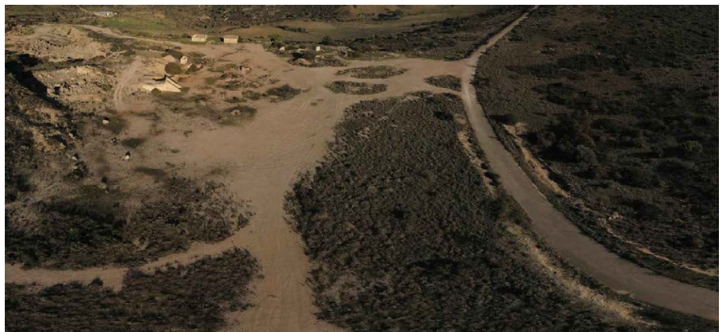
Fig. 13 – Area individuata per l'accantieramento
