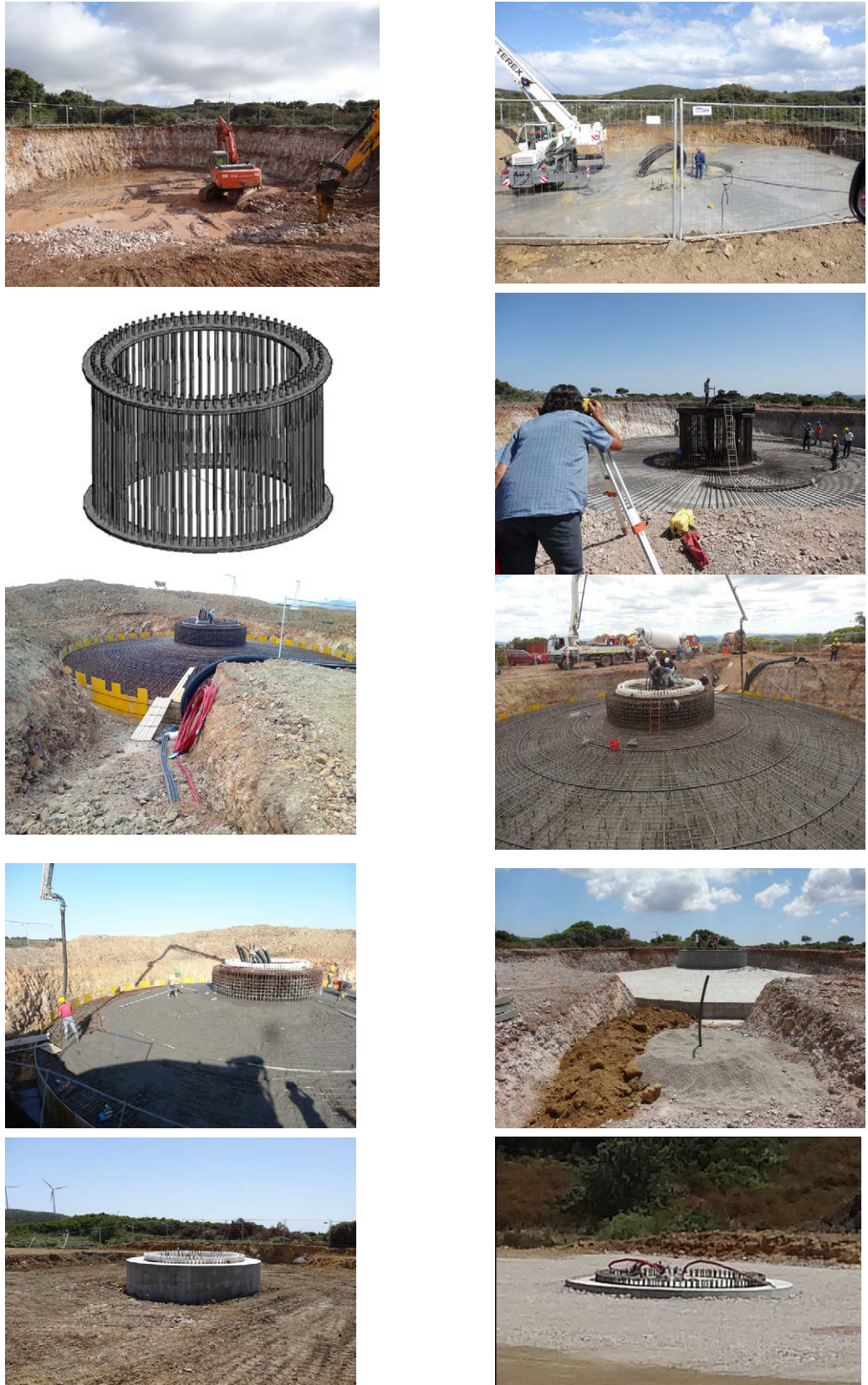
Fig. 28 – Fasi realizzative fondazioni
