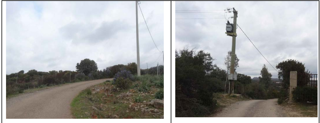
Fig. 26 – Pali e linee elettriche lungo i tracciati di progetto
