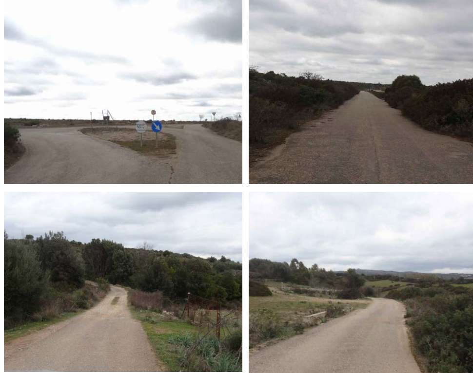
Viabilità secondaria comunale esistente - tratti asfaltati
