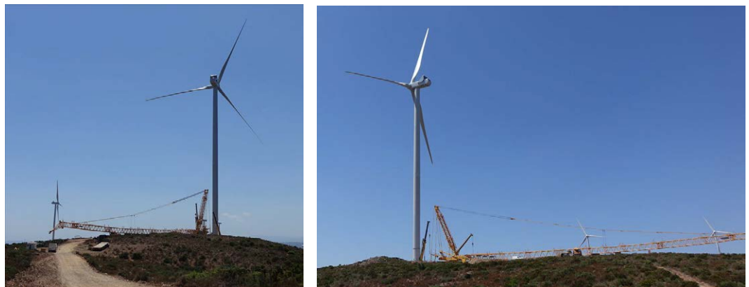
Fig. 31 – Spazi di montaggio per la gru principale
