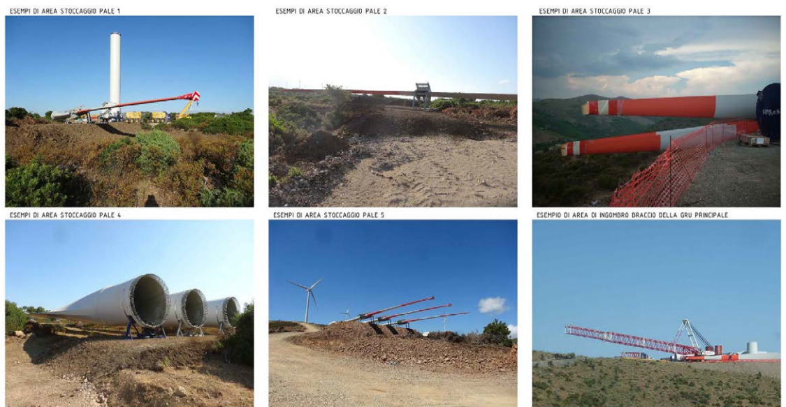
Fig. 29 – Esempi di stoccaggio pale
