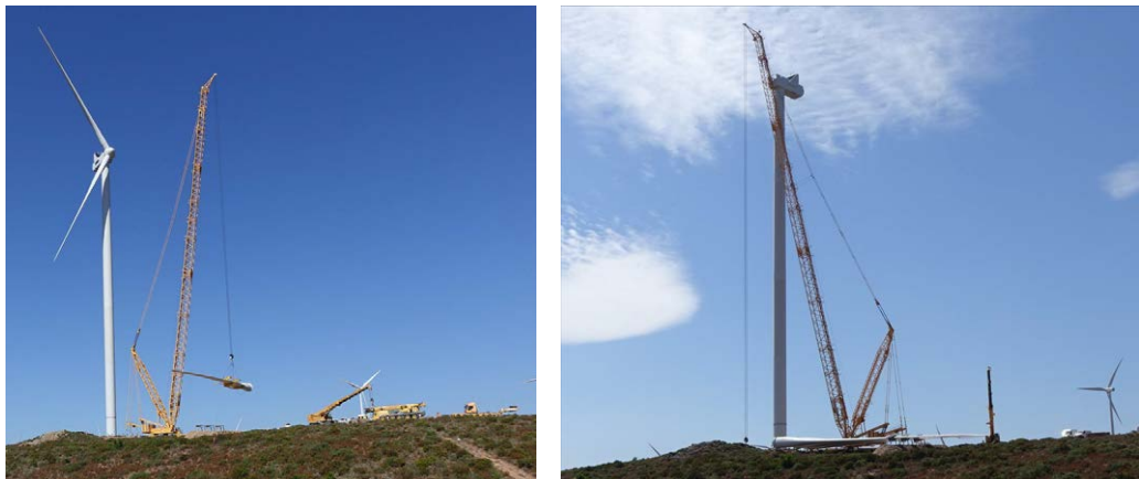
Fig. 34 – Operazioni di montaggio con gru
