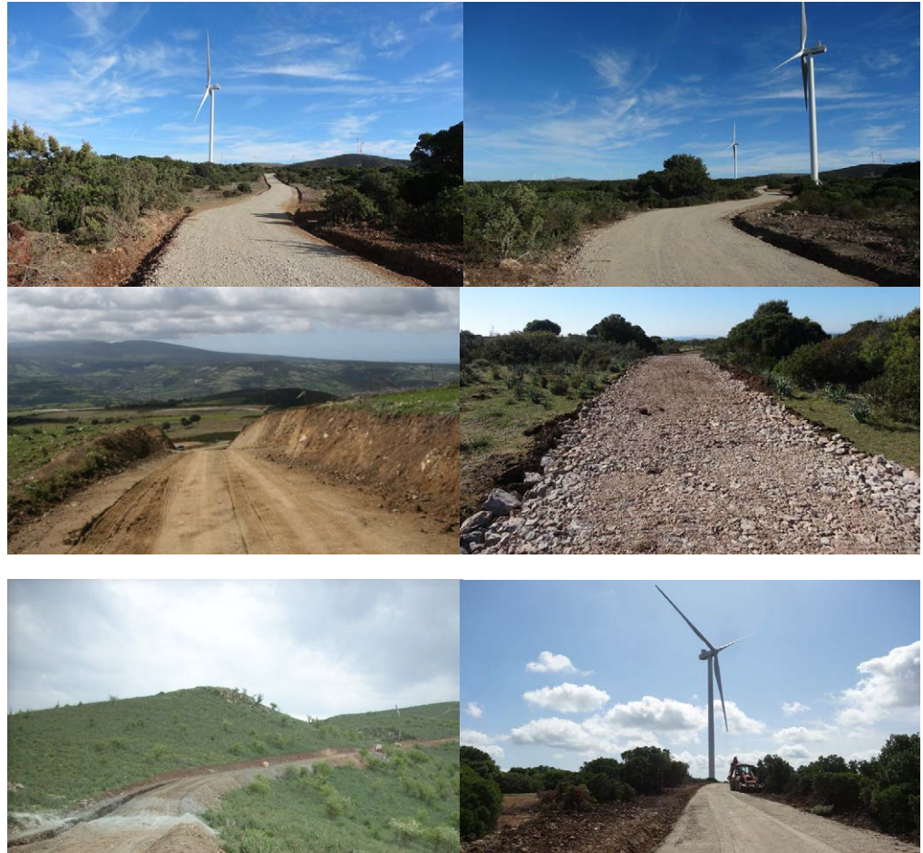
Fig. 17 – Realizzazioni tipiche di strade per parchi eolici
