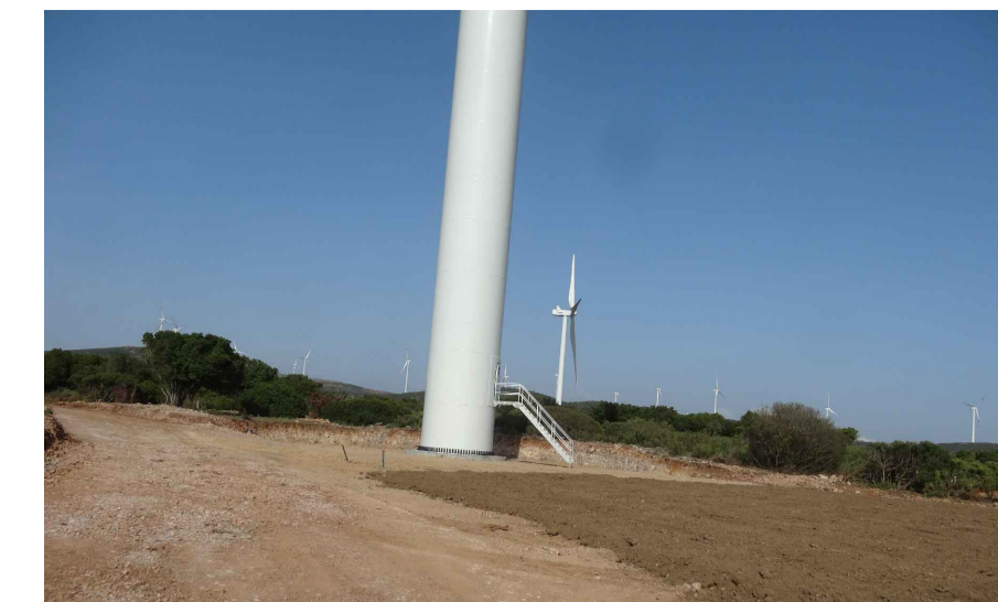
Completamento fase realizzativa impianto con estensione terra vegetale. (settembre 2019)
