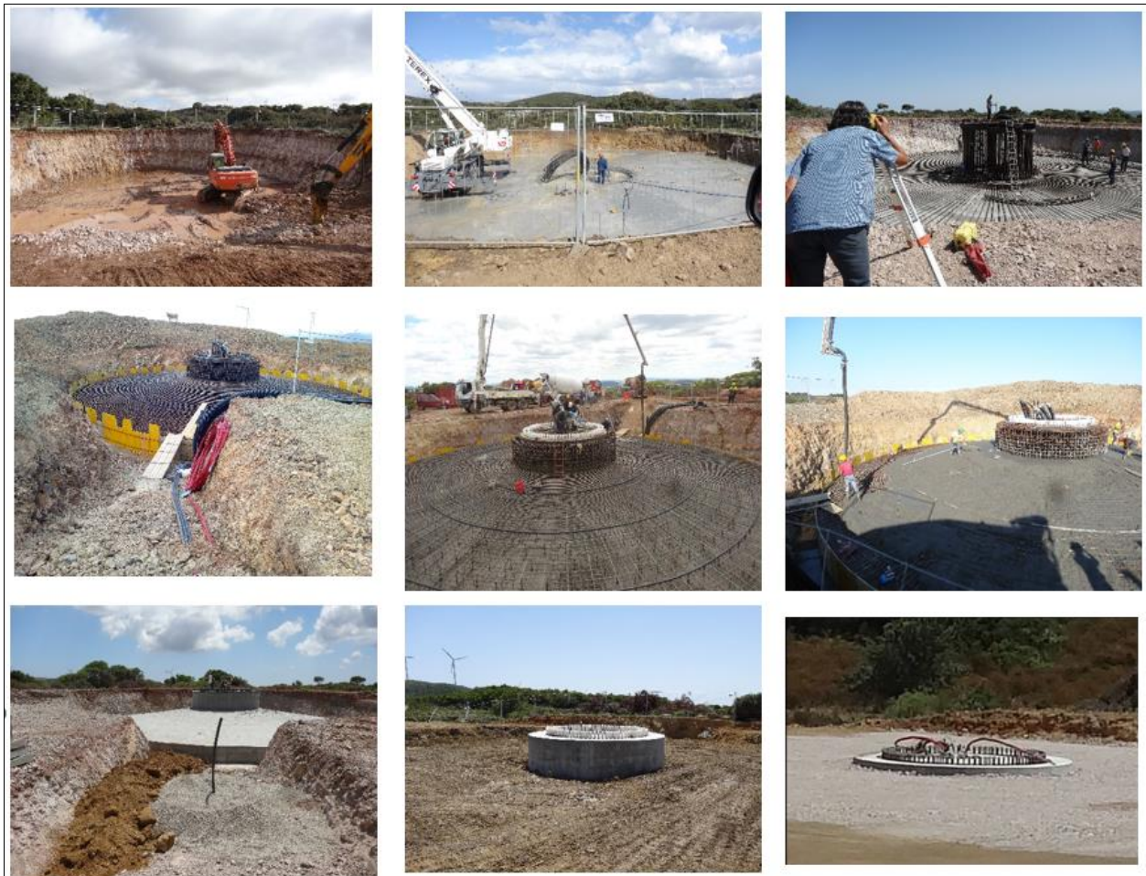
Figura 38 – Fasi di realizzazione delle fondazioni
