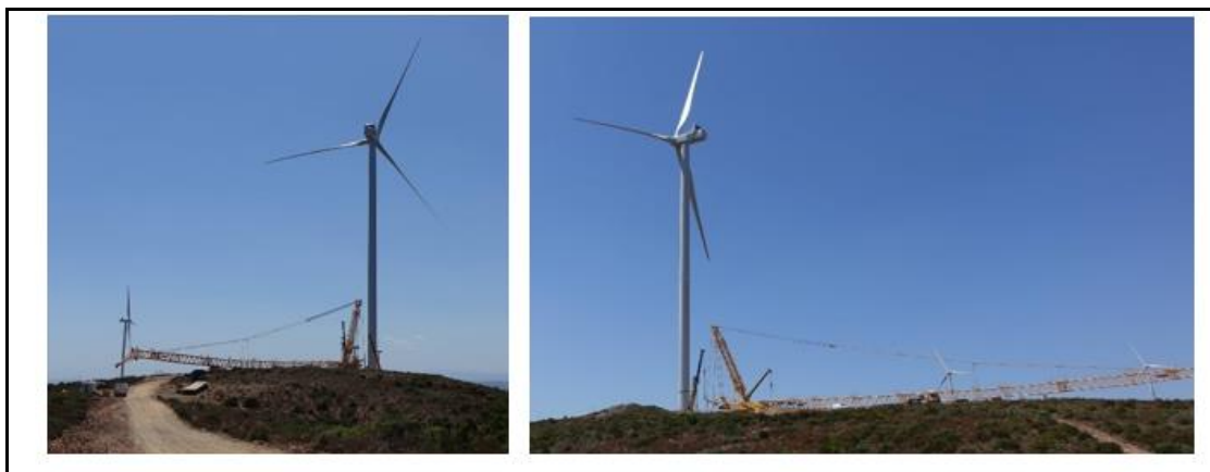
Figura 41 – Spazi per il montaggio delle gru principale
