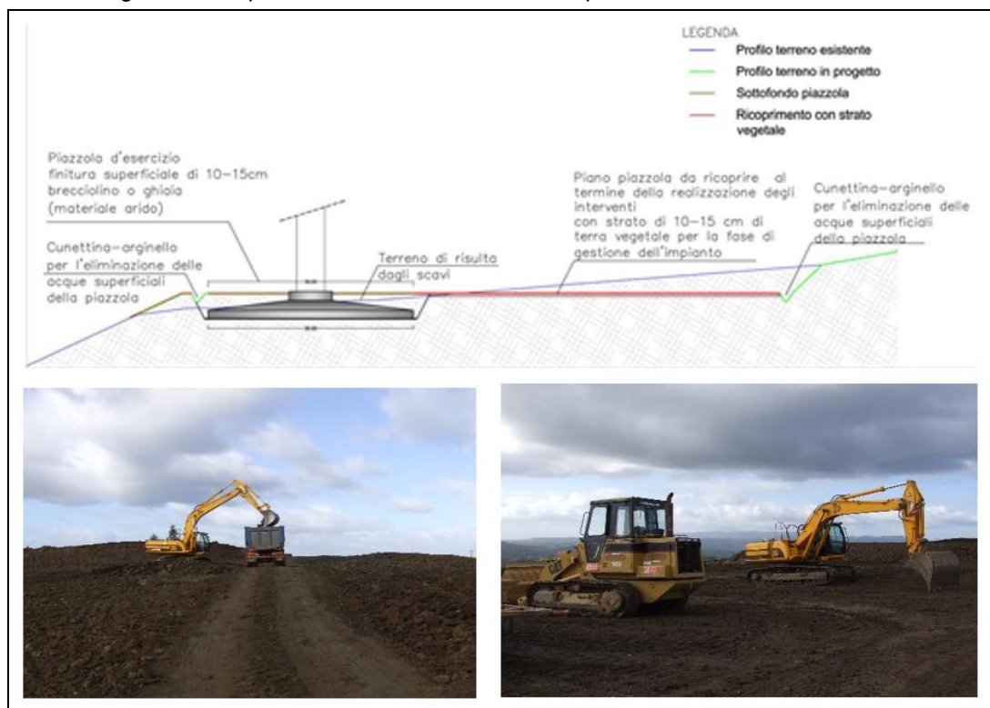
Figura 42 – Operazioni di realizzazione della piazzola e sistemazione finale
