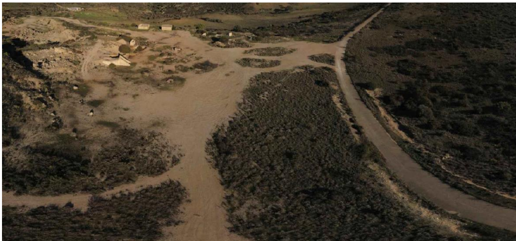
Figura 87 – Foto aerea scattata dal drone dell'area di cantiere individuata
