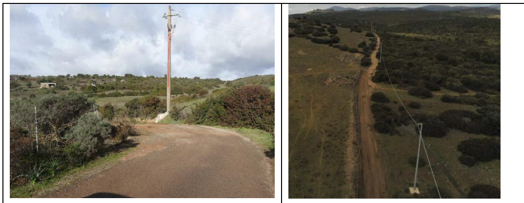
Figura 35 - Potenziali interferenze per linee elettriche sui tracciati per le wtg ESC10 e ESC13.
