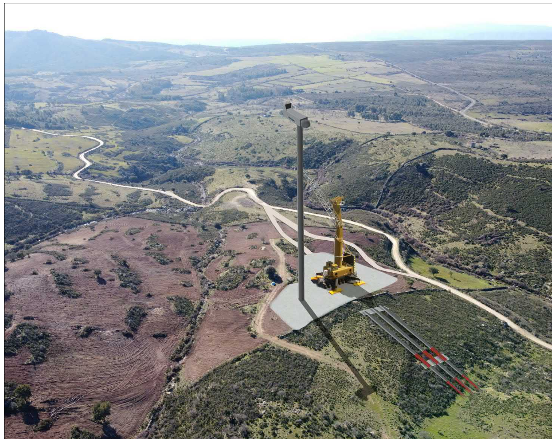
Stato di cantiere
