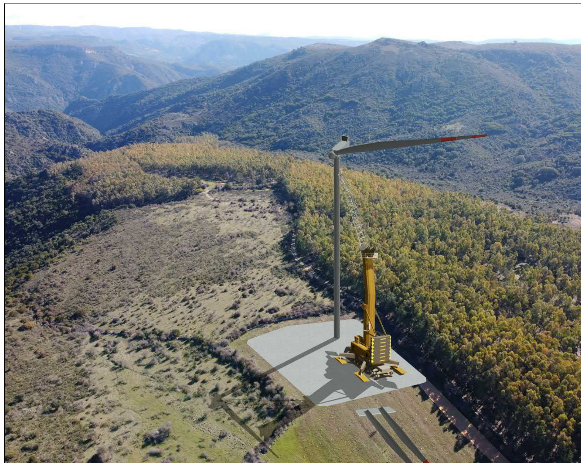
Stato di cantiere
