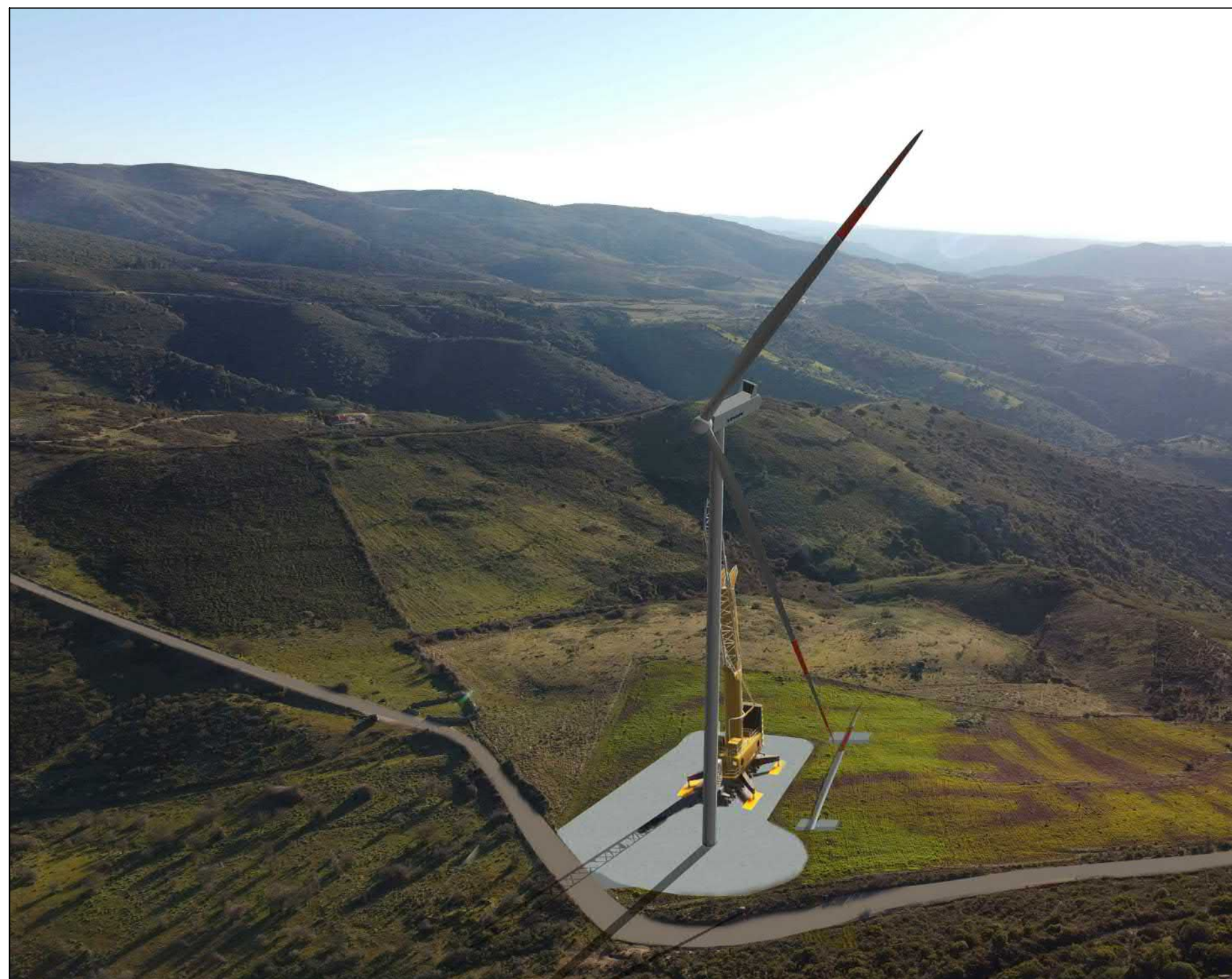
Stato di cantiere
