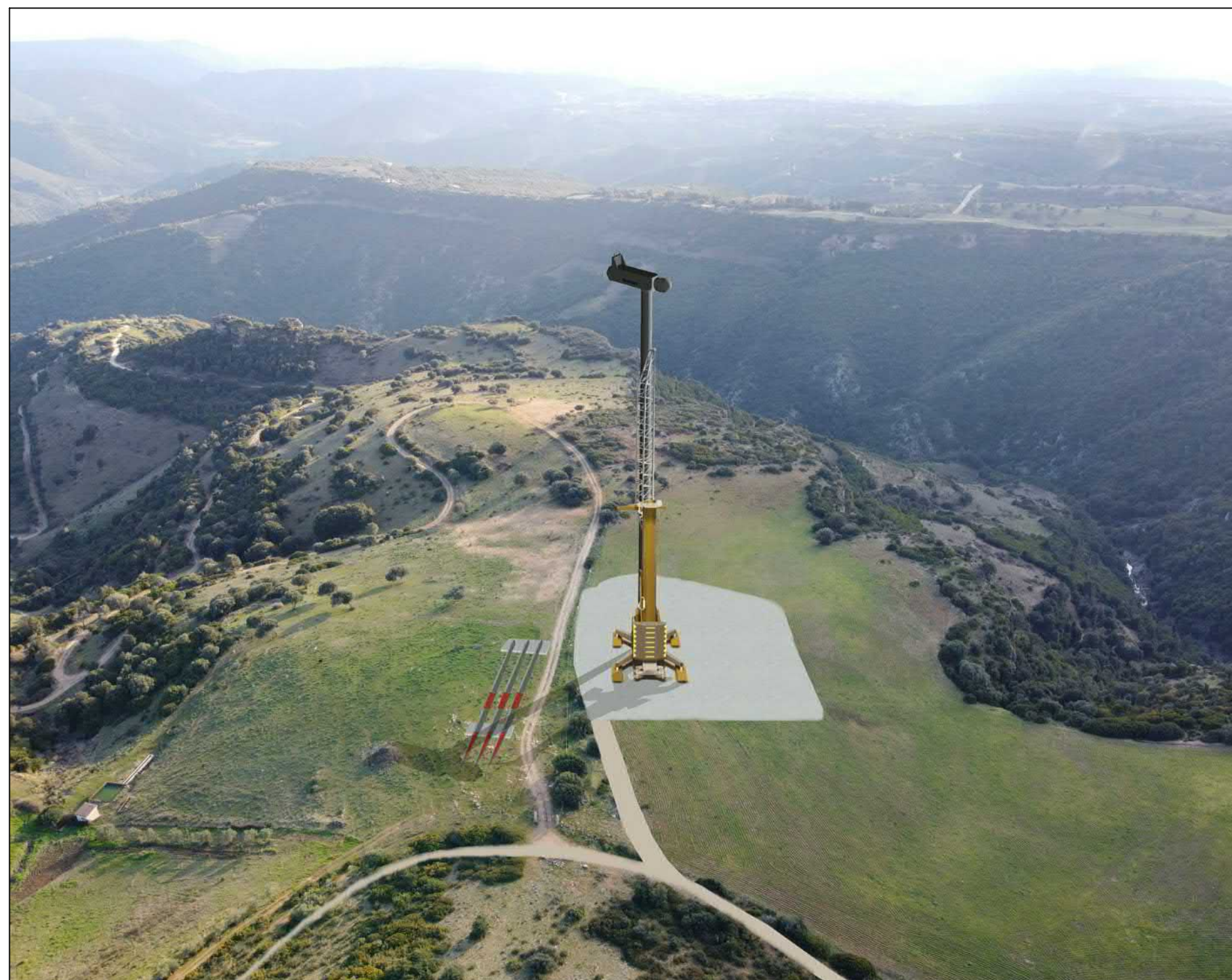
Stato di cantiere
