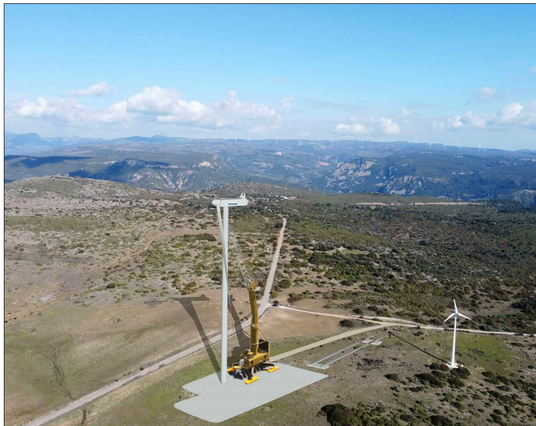
Stato di cantiere
