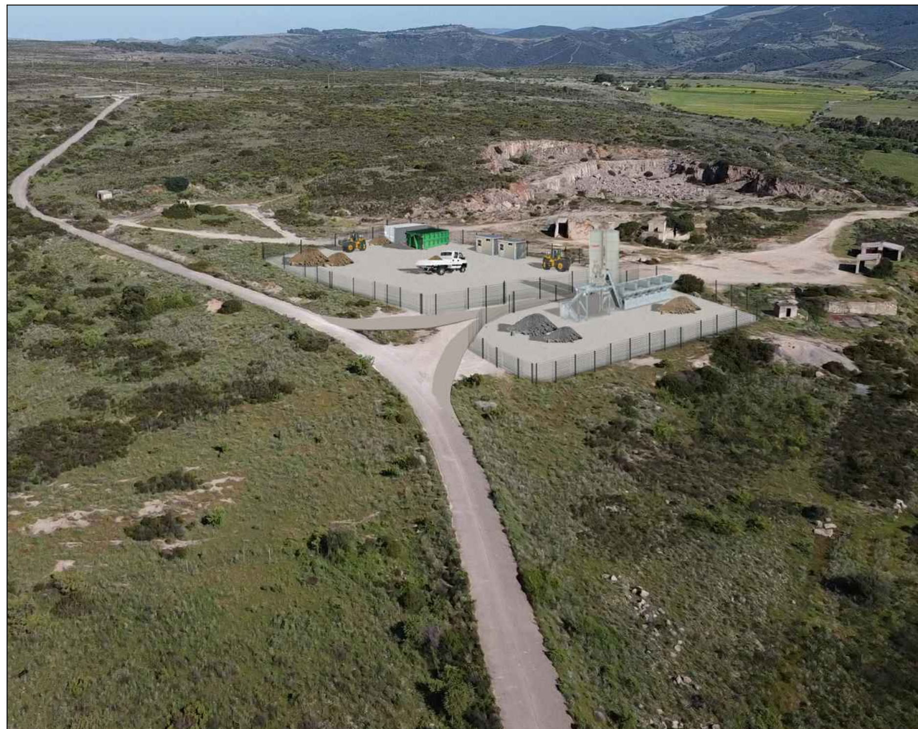
Stato di cantiere
