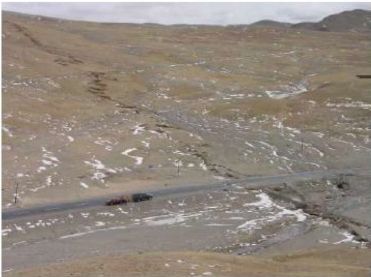
Fig. 24 - Rottura di un oleodotto sepolto a causa di un terremoto nel 2001 vicino a Qinghai-Xinjiang, Cina. La foto mostra la rottura del suolo a causa di una faglia trascorrente che attraversa la strada perpendicolarmente e che è stata caratterizzata da un rigetto orizzontale di 3,5 metri e da uno verticale di 0,8 metri. L'oleodotto attraversa la strada nello stesso punto in cui viene attraversata dalla faglia (Fig. 25).
