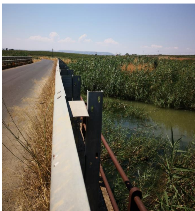
Figura 3-23 – Attraversamento vallone Sbarda l'Asino
