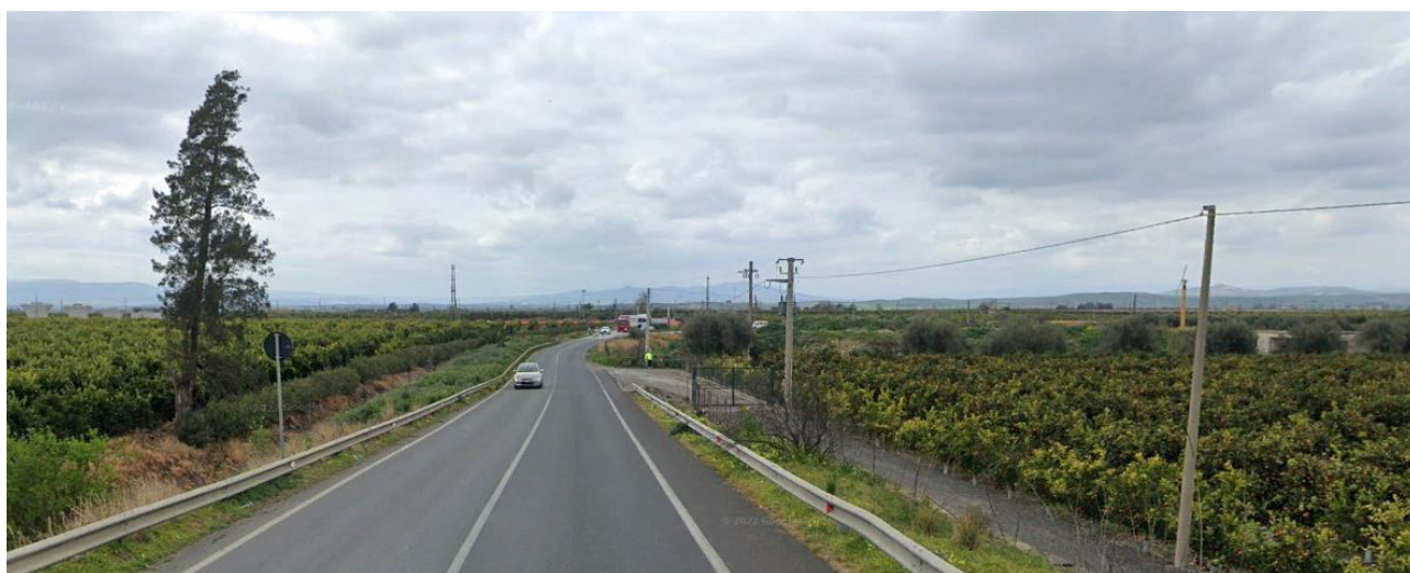
Figura 4-30 – Vista da piano strada tratto panoramico SP24/SS192
