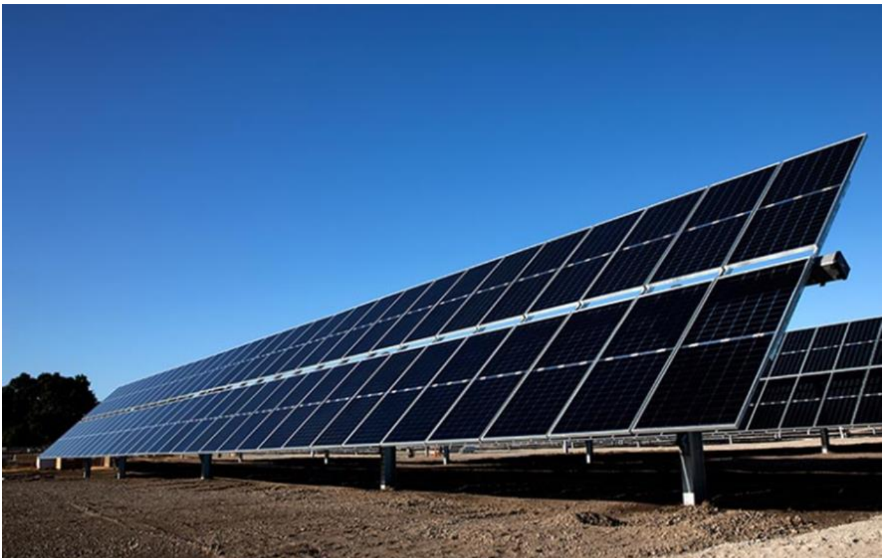
Figura 3-6 – Tipico tracker fotovoltaico in configurazione "2-Portrait"
