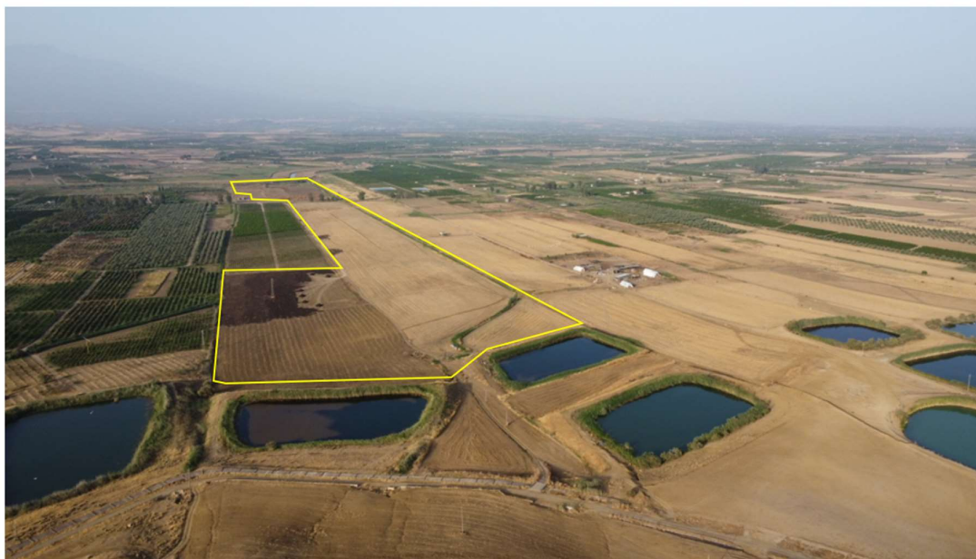
Figura 2-4 – Vista ripresa con drone da sud-ovest verso nord-est
