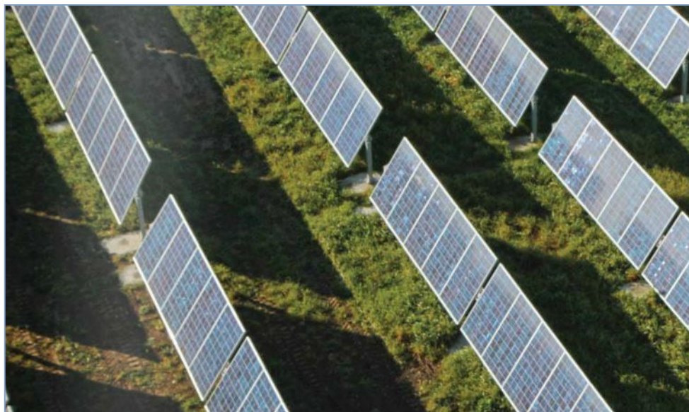
Fig. 6: esempio di tracker ad asse variabile
