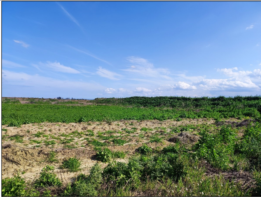
UR 6 – area della stazione elettrica con in evidenza il bacino idrico
