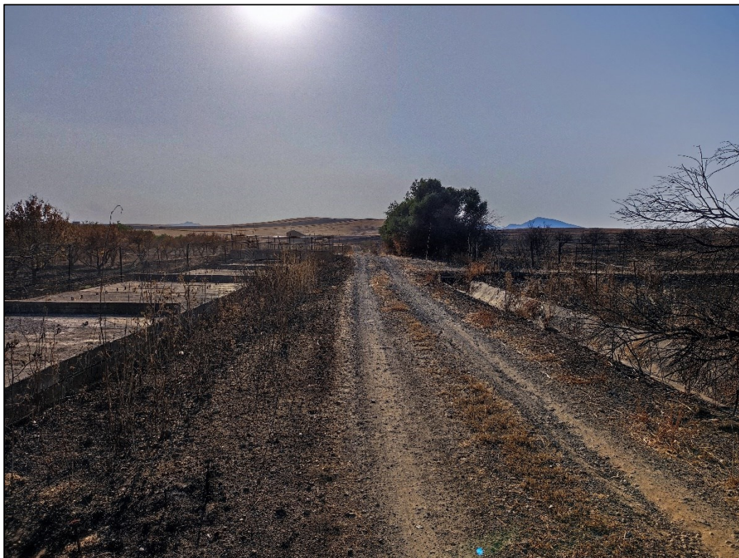
Fig. 22: cavidotto lungo la strada consortile presso l'impianto
