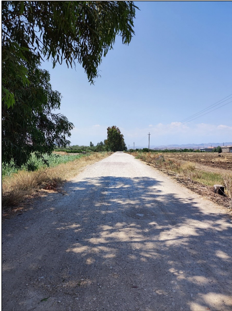
Fig. 17: strada senza denominazione in prossimità dell'impianto
