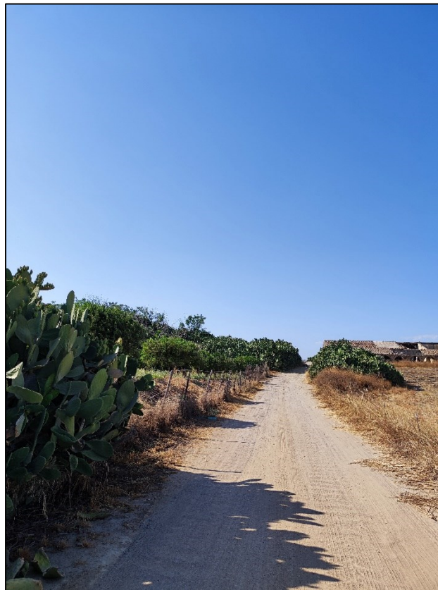
Fig. 19: percorso dell'elettrodotto su strada asfaltata in prossimità dell'impianto
