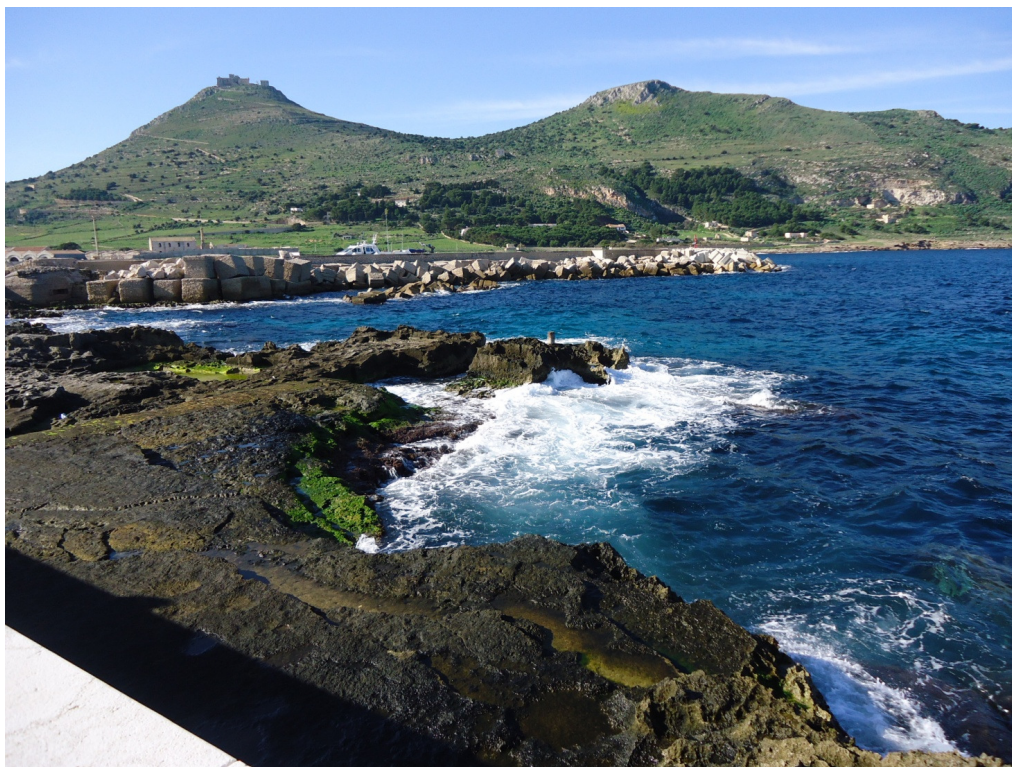
Figura C7.1 - Sito d'intervento – stato dei luoghi
