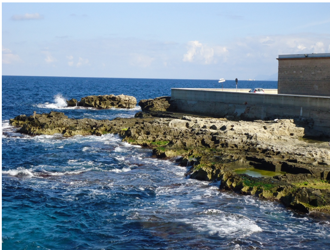
Figura C7.2 - Sito d'intervento – stato dei luoghi
