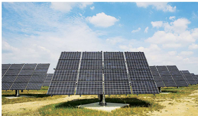
Figura 2-3 – Tipologico tracker ad inseguimento biassiale
