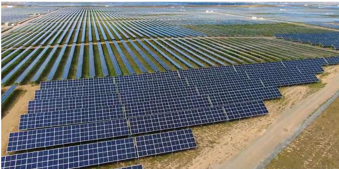
Figura 2-2 – Differenza di occupazione tra impianti ad inseguimento monoassiale e fissi
