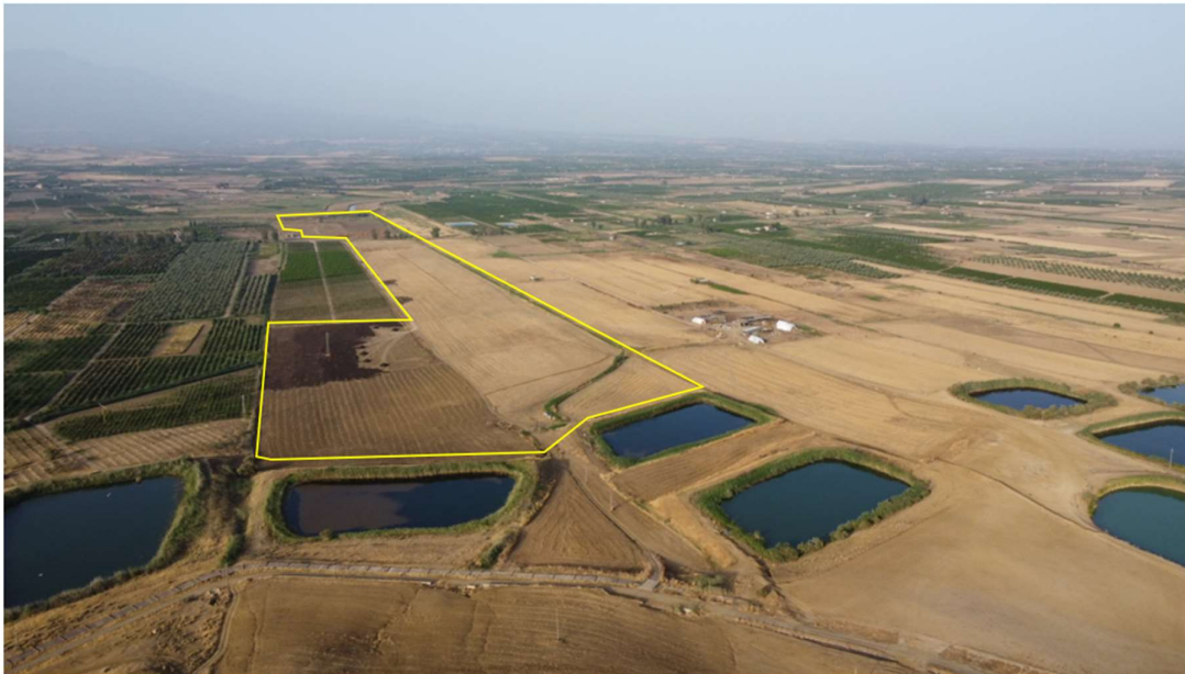
Figura 3.2-1 – Vista ripresa con drone da sud-ovest verso nord-est
