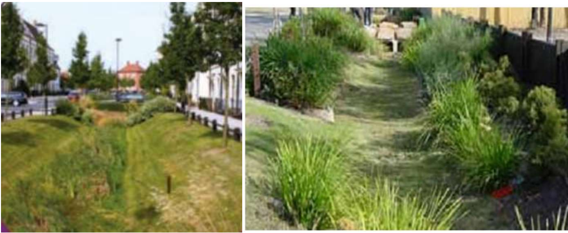
Figura 8-1 Esempio di depressioni con funzione di laminazione
