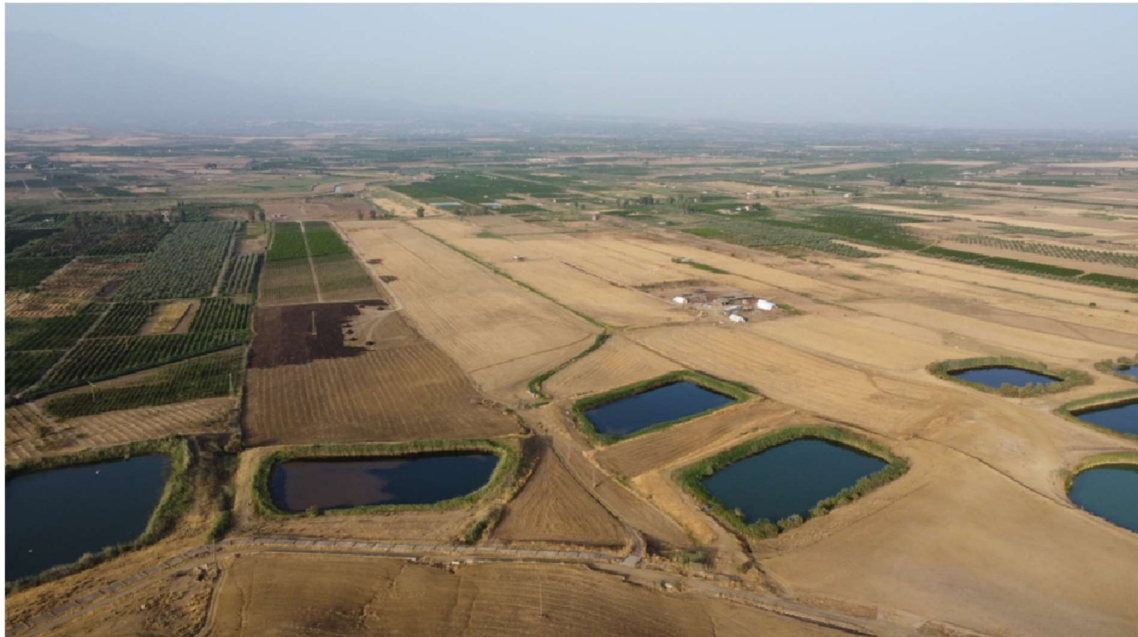
Figura 5-12 – Scatto con drone D1 ante-operam – Elevazione della zona a sud dell'area di impianto
