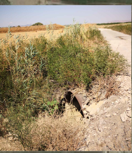
INT-12: Attraversamento tubatura DN400 canale di scolo T.O.C. - km. 10,49
