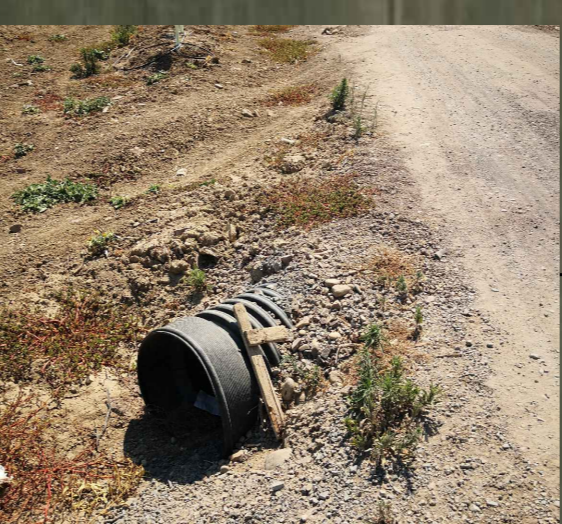
INT-13: Attraversamento tubatura DN400 canale di scolo T.O.C. - km. 10,54
