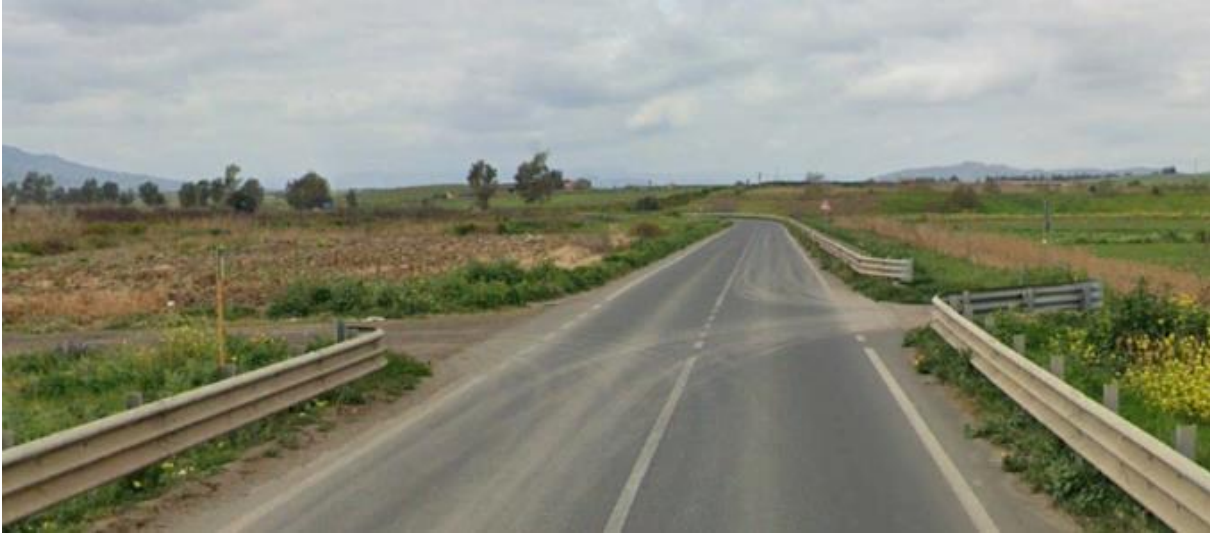
Figura 6-18 – Viabilità SS288 in corrispondenza del tracciato del cavidotto interrato e della Regia Trazzera n. 477
