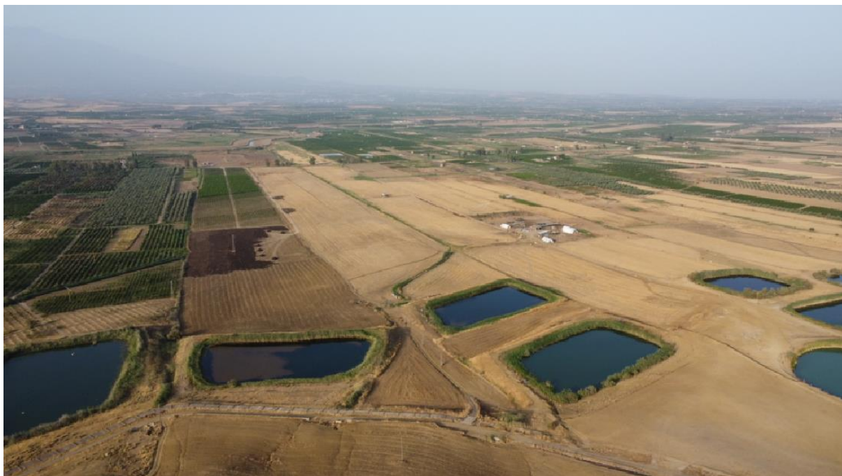
Figura 7-17 – Scatto da punto PdV6 ante-operam – Area impianto (drone)
