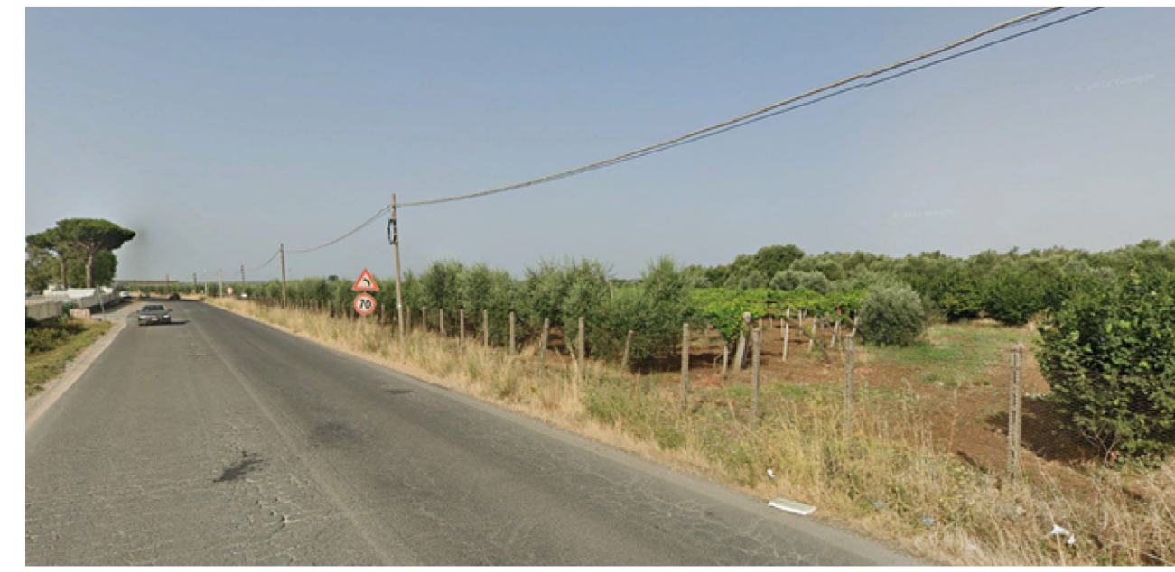
STATO POST INTERVENTO
