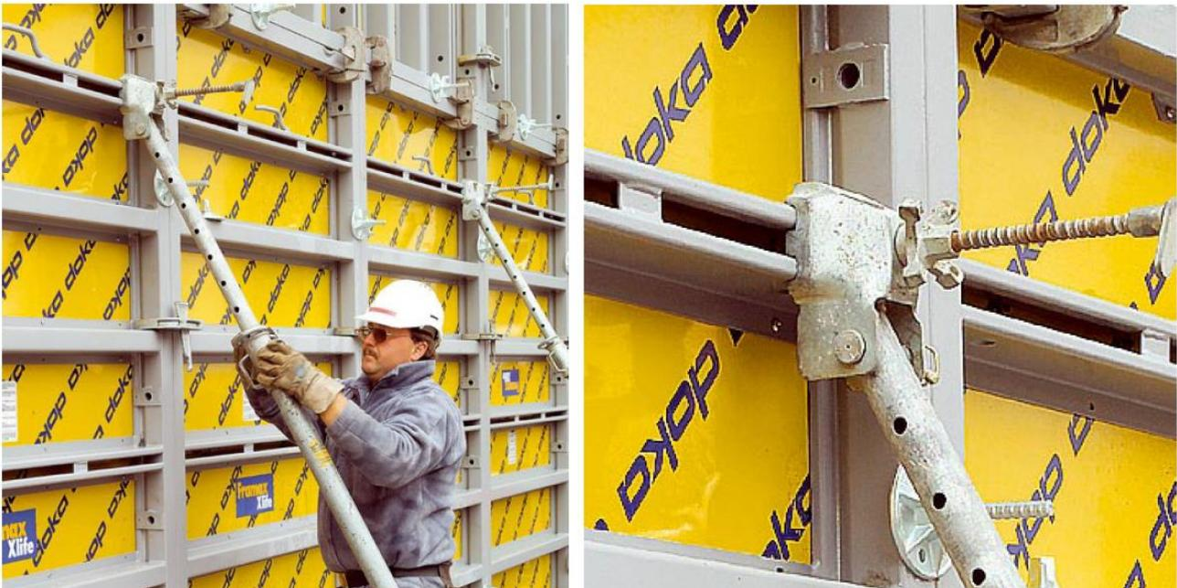
Le rotaie di raccordo presenti su tutta la larghezza degli elementi consentono un collegamento rapido di accessori quali puntellazioni di sostegno, rotaie di fissaggio e passerelle di getto, velocemente e senza punti obbligati.
