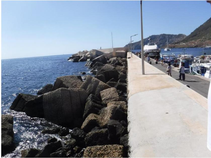
Figura 11 - Tratto di molo da sottoporre a ricarica della mantellata esterna (quota sommitale muro: + 3,5 s.l.m.)
