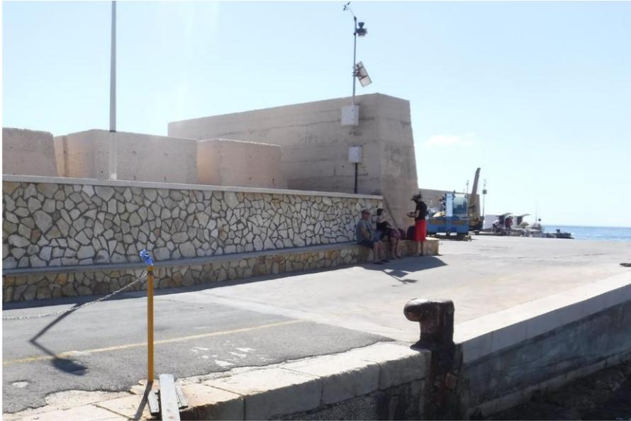
Figura 13 - Inizio tratto muro paraonde a quota + 6,30 s.l.m. (tratto non rivestito fino alla testata)
