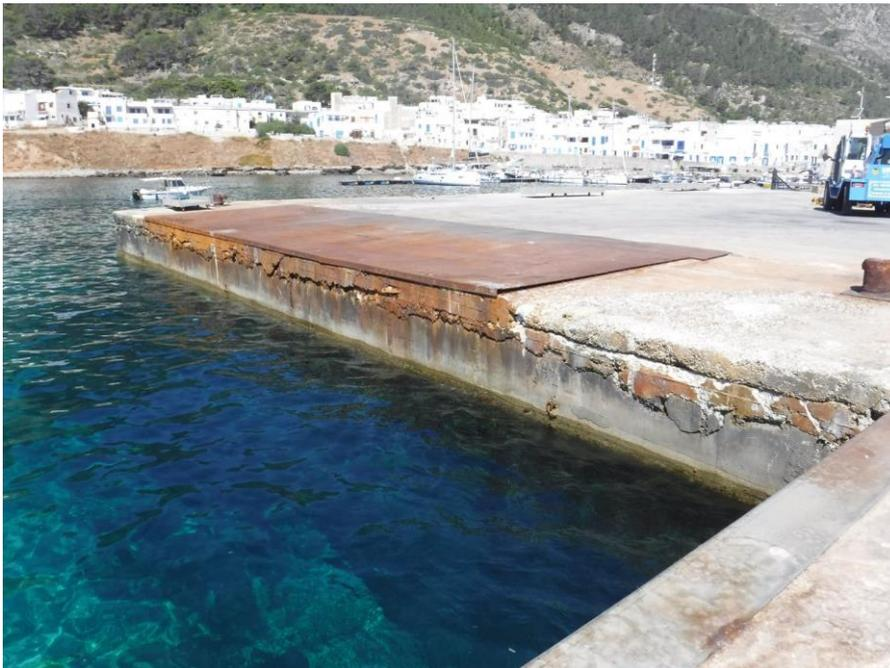
Figura 14 - Banchina per attracco navi traghetto (attracco di poppa) e sullo sfondo pontile galleggiante per imbarcazioni da diporto
