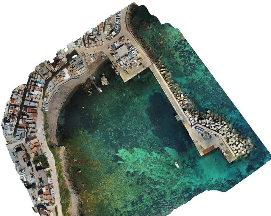
Figura 3- Foto aerea dell'area di intervento a terra
