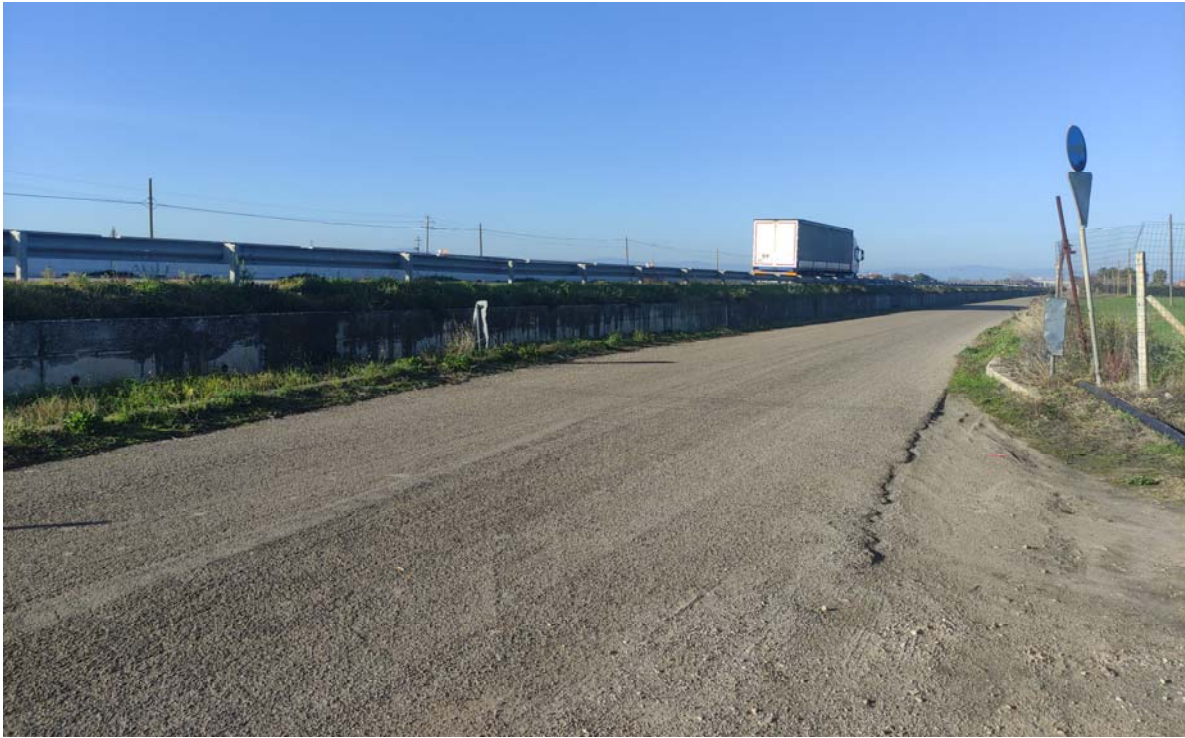
Punto di presa dalla Masseria Mari – Stato di fatto
