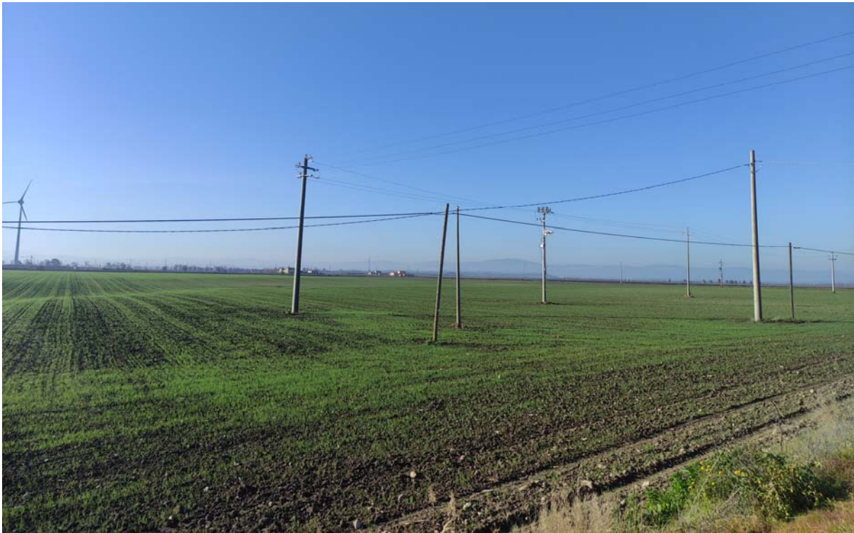
Punto di presa dalla strada complanare alla SS 17 – Stato di fatto.
