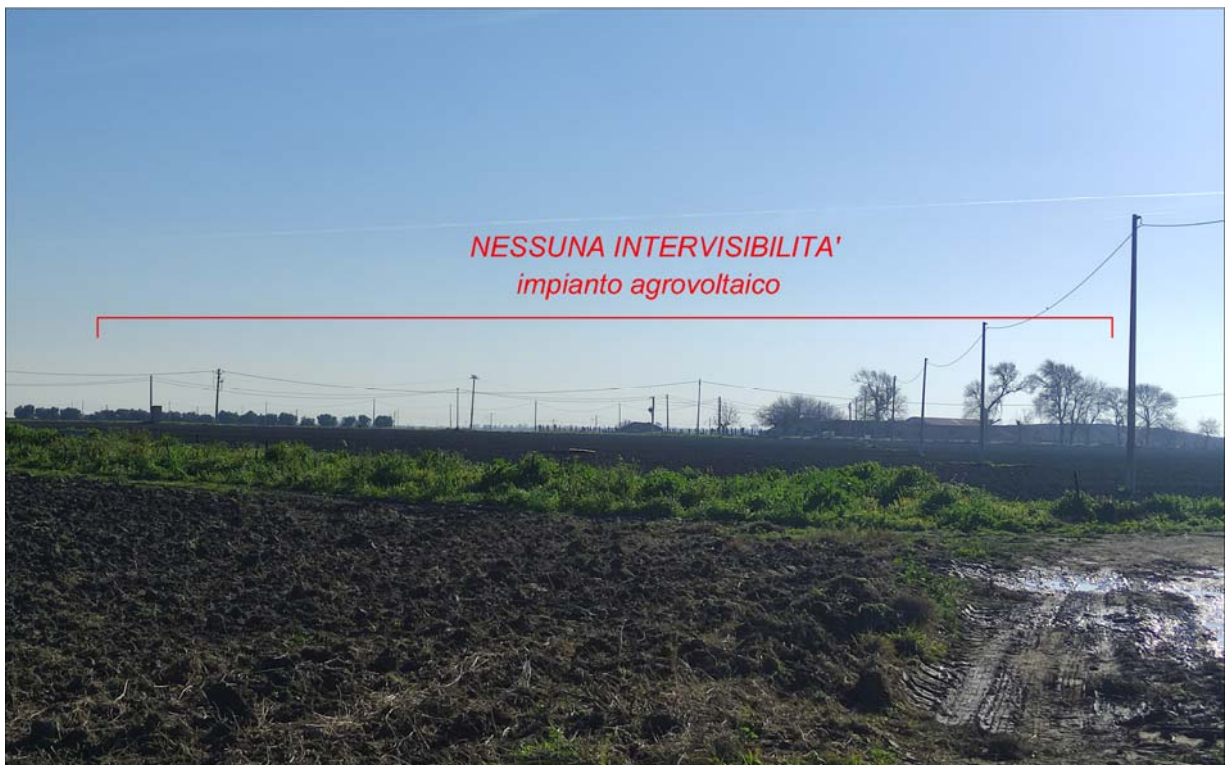
Punto di presa dal Regio tratturo Celano – Foggia – Stato di progetto. L'impianto non risulta visibile.
