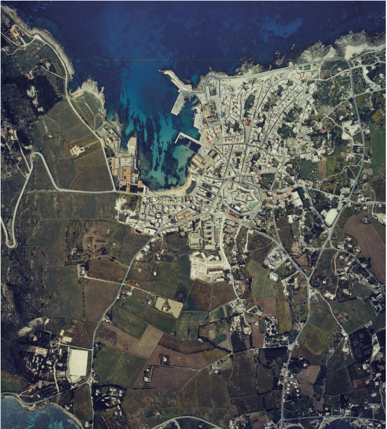
Figura 2 - Vista aerea del Porto di Favignana (cala principale)
