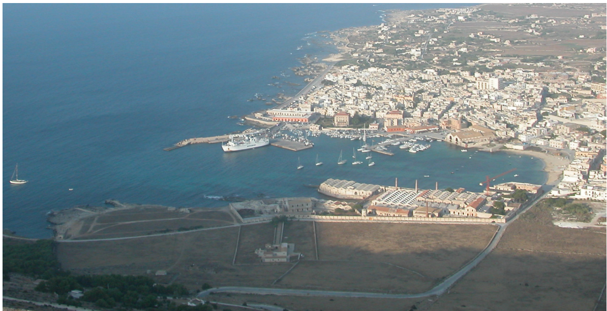
Figura 46 - Vista d'insieme da terra dell'area d'intervento
