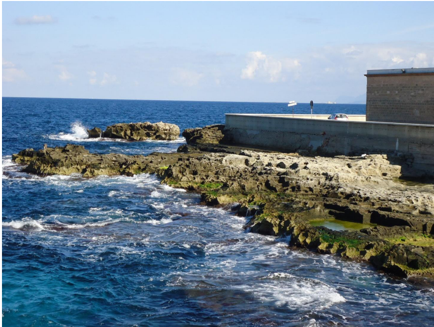
Figura 23 - Sito d'intervento – stato dei luoghi
