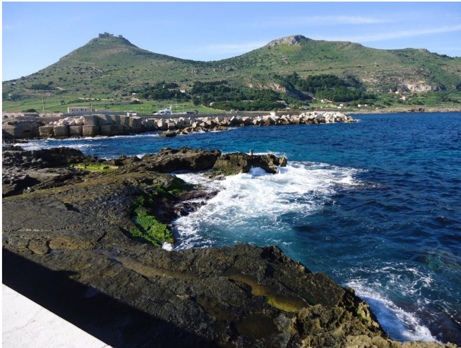
Figura 22 - Sito d'intervento - stato dei luoghi
