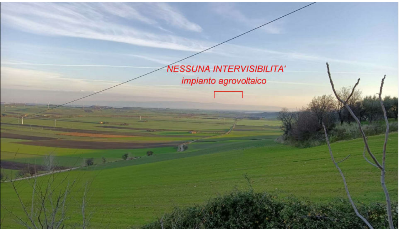
Punto di presa dalla strada SP 109 "Strada panoramica Troia – Vaccarella" – Stato di fatto. L'impianto non risulta percettibile data la notevole distanza.
