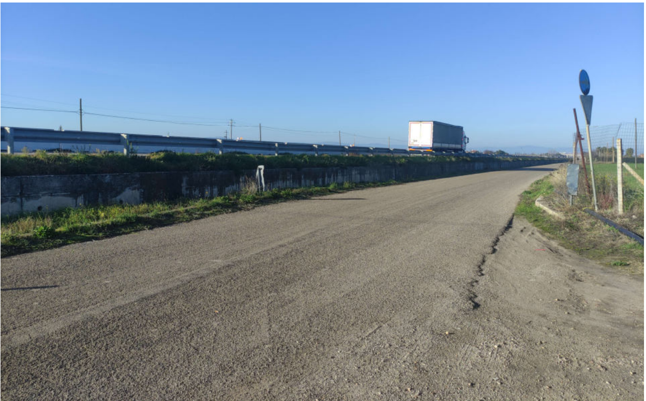
Punto di presa dalla Masseria Mari – Stato di fatto
