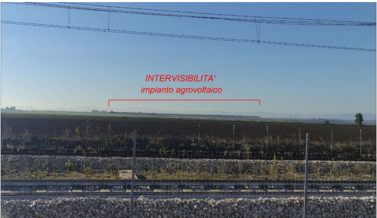
Punto di presa dal Regio tratturo Celano – Foggia, nei pressi della fermata ferroviaria di "Vaccarella" – Stato di progetto. L'impianto risulta poco visibile; inoltre risulta visibile perlopiù la fascia arborea di mitigazione esterna alle aree recintate.
