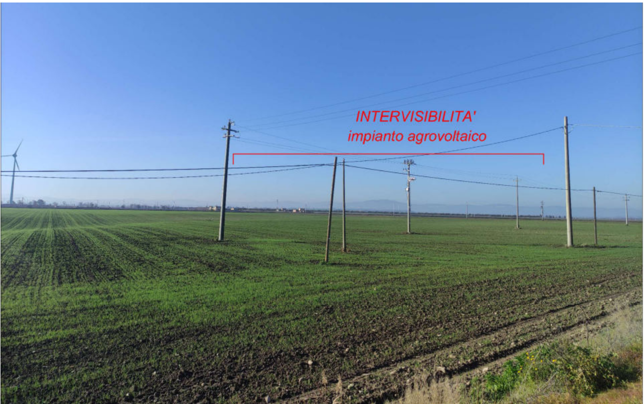
Punto di presa dalla strada complanare alla SS 17 – Stato di progetto. L'impianto risulta poco visibile; inoltre risulta visibile perlopiù la fascia arborea di mitigazione esterna alle aree recintate.
