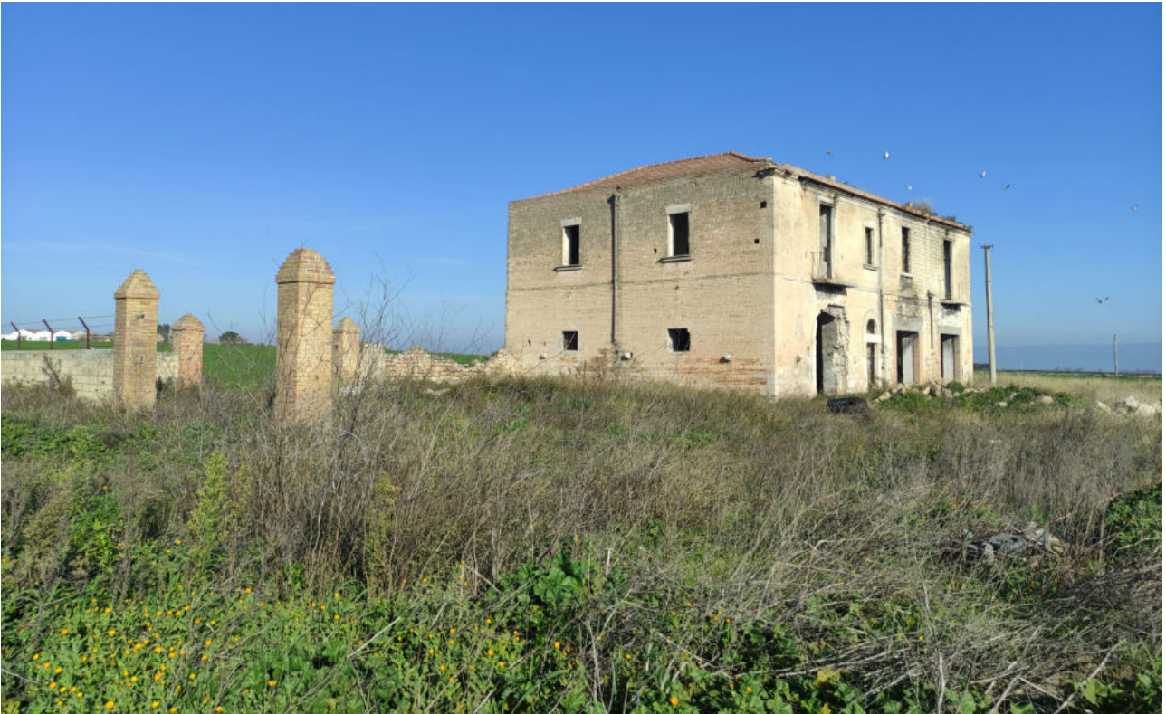
Punto di presa dalla Masseria S. Antonio – Stato di fatto. La masseria è di proprietà privata e non è accessibile. Il punto di presa è stato fissato dal suo accesso.
