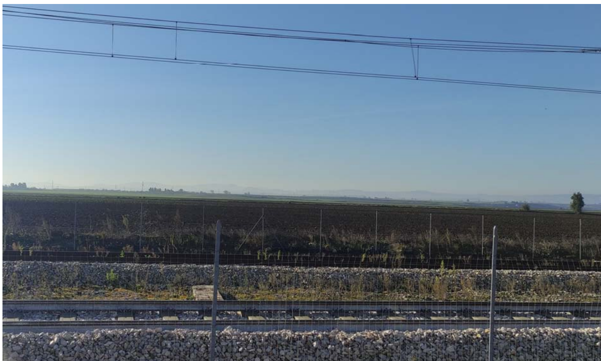
Punto di presa dal Regio tratturo Celano – Foggia, nei pressi della fermata ferroviaria di “Vaccarella” – Stato di fatto
