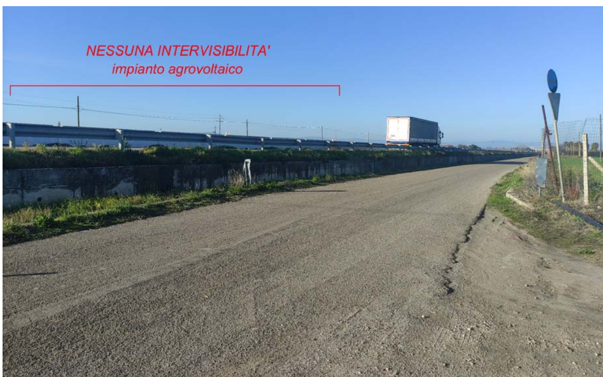
Punto di presa dalla Masseria Mari – Stato di progetto. L'impianto non risulta visibile
