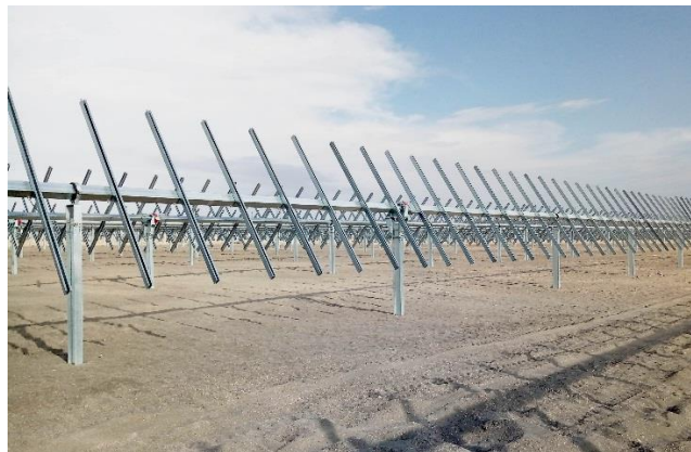
Rappresentazione della struttura di supporto – vista frontale
