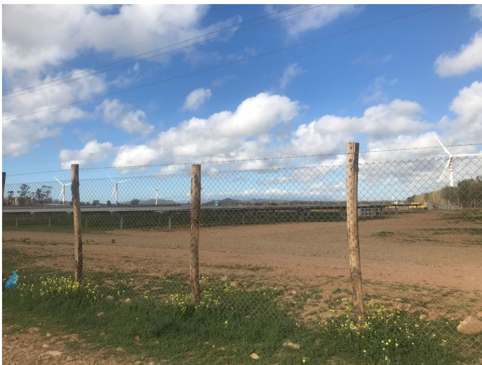
Figure 1-23. Tipologia di recinzione utilizzata
