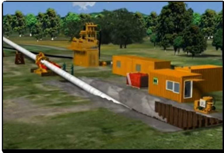
Figure 1-19. Tecnica "Microtunneling"
