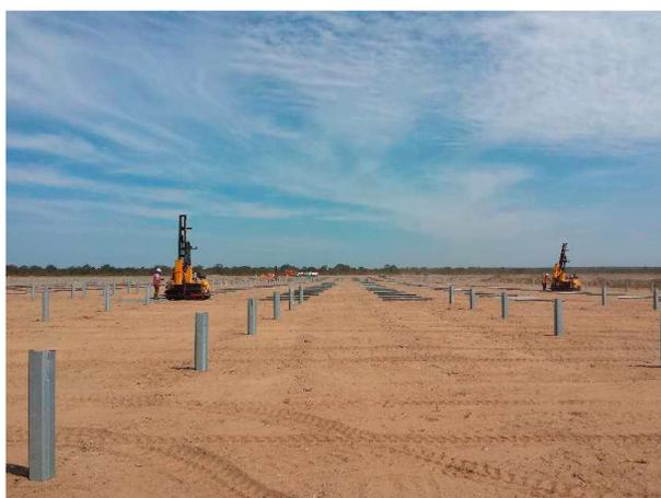
Il supporto post guidato non richiede una base concreta. Il palo è un profilo in acciaio omega per massimizzare la superficie di contatto con il terreno, la profondità dipende dal tipo di terreno.
