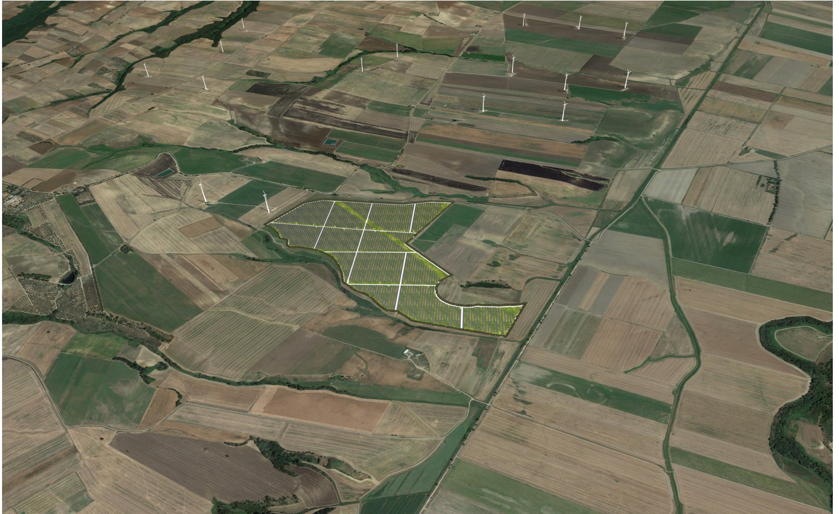
Figure 3-8 Veduta generale dell'intervento da sud
