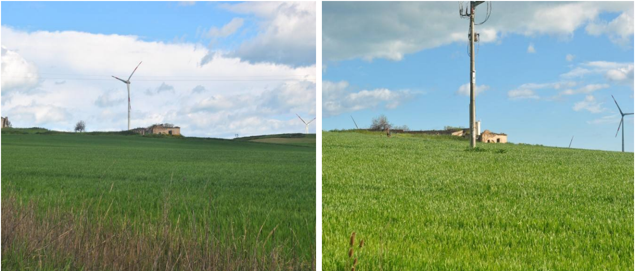
Figure 5-7. Masseria Chiantinelle – scatto fotografico n.2 - (condizione di degrado diffuso ed abbandono)
