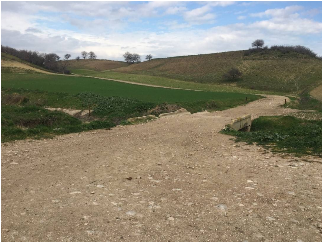
Figure 5-3. Strada interpodereale tratto attraversato con tecnica no dig
