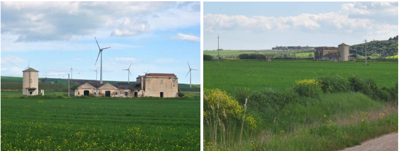
Figure 5-8. Masseria L'Ischione Vecchio – scatto fotografico n.3 - (condizione di degrado diffuso e abbandono)
