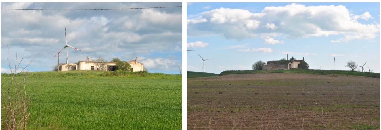
Figure 5-6. Masseria Inforchia – scatto fotografico n.1 - (condizione di degrado diffuso ed abbandono)
