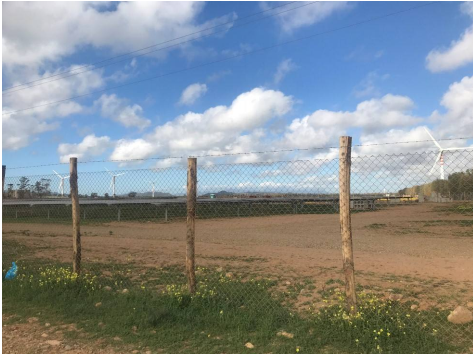
Figure 4-23. Tipologia di recinzione utilizzata
