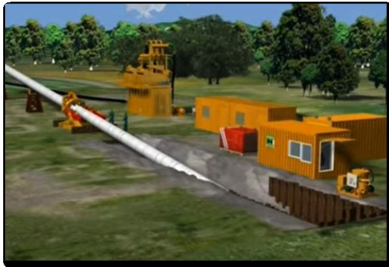
Figure 2-19. Tecnica "Microtunneling"
