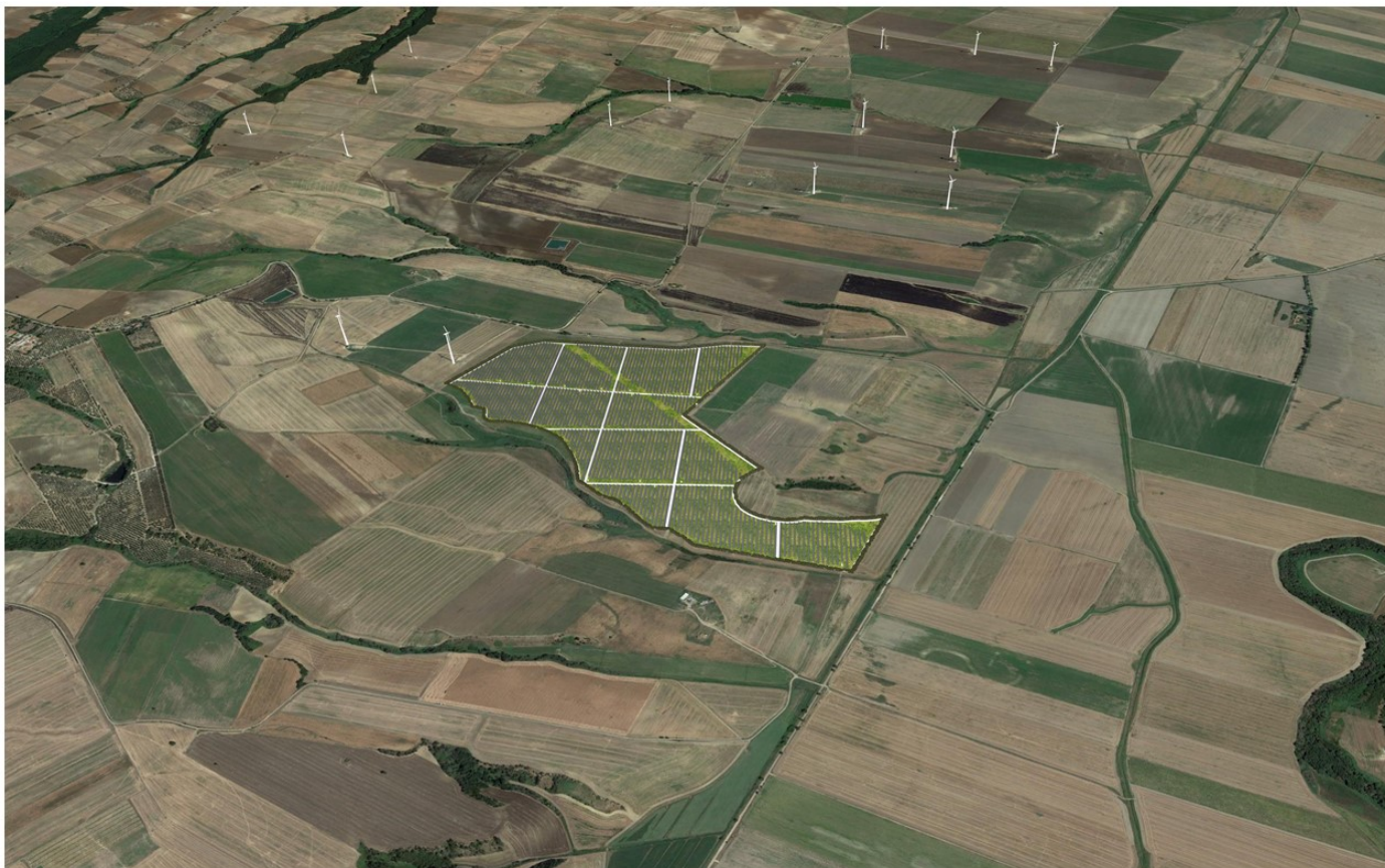
Figura 5-13. Veduta generale dell'intervento da sud
