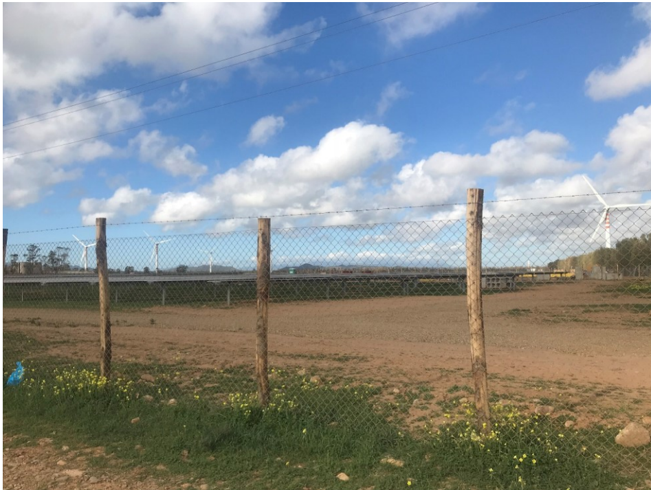
Figure 2-19. Tipologia di recinzione utilizzata
