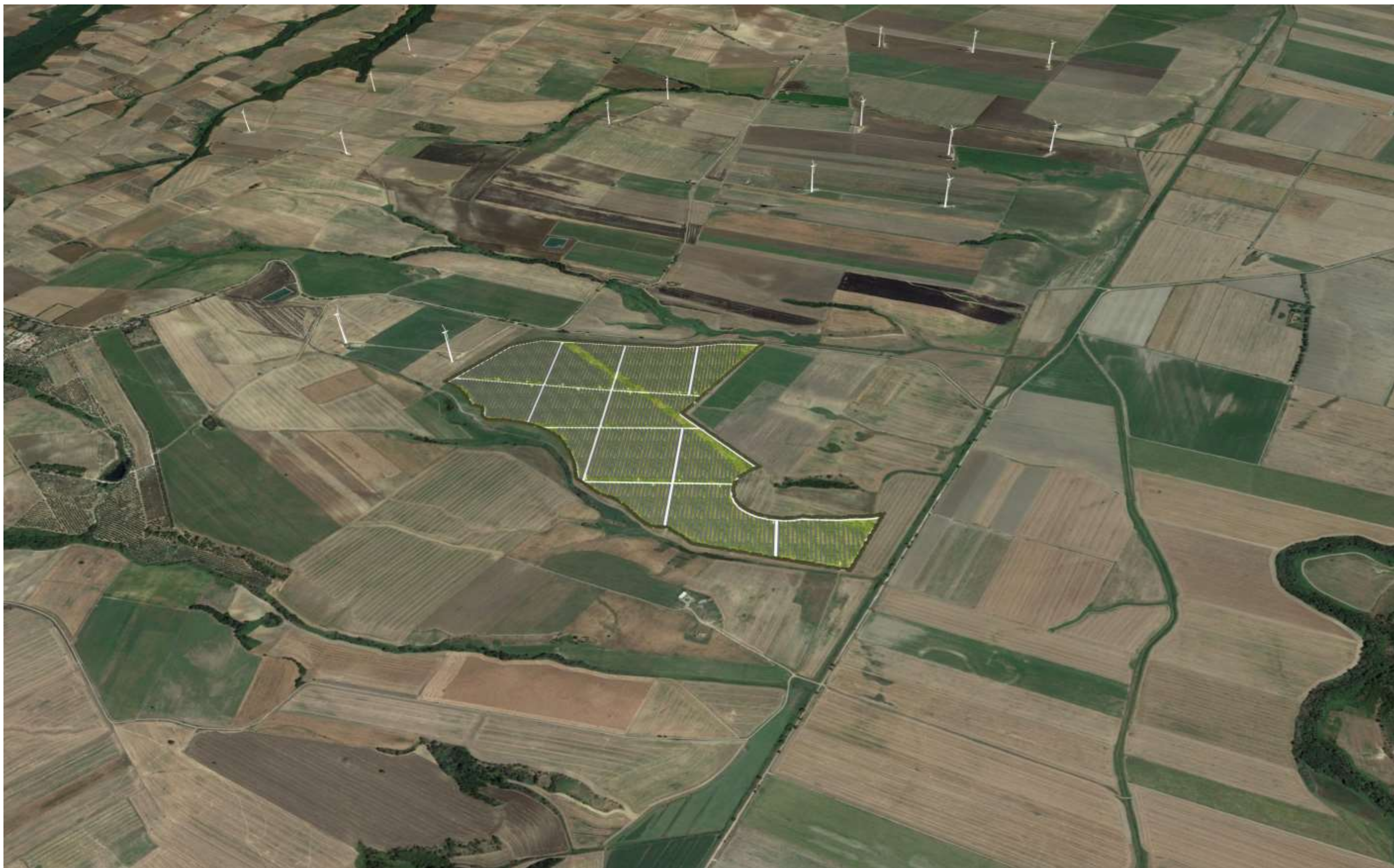
Figure 7-20 Veduta generale dell'intervento da sud
