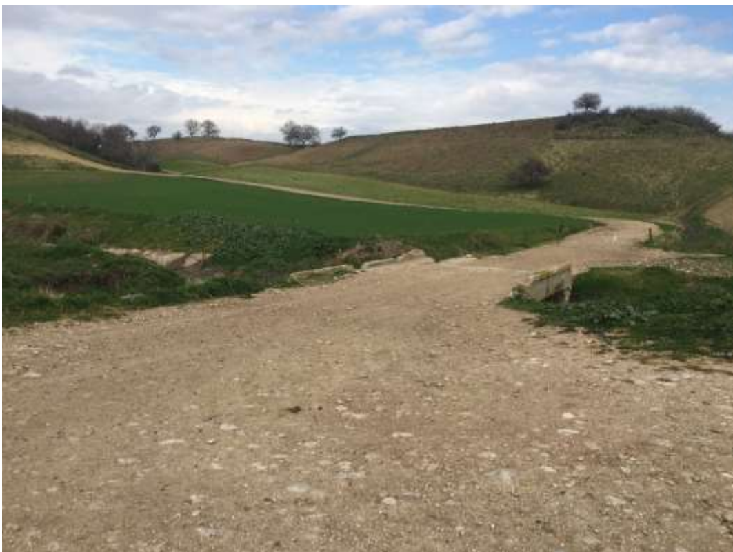
Figura 3-10 Strada interpoderale tratto attraversato con tecnica no dig
