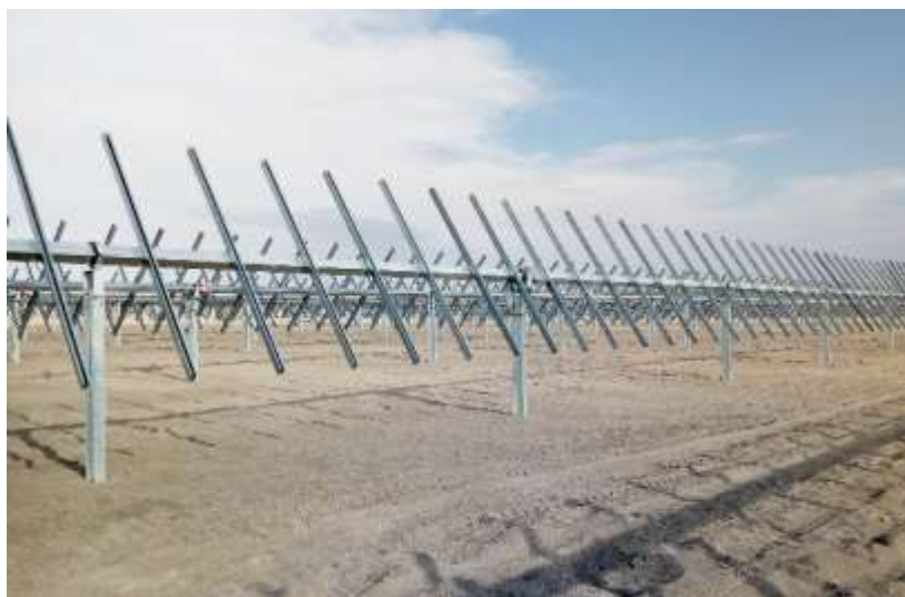
Figure 6-3 Rappresentazione della struttura di supporto
