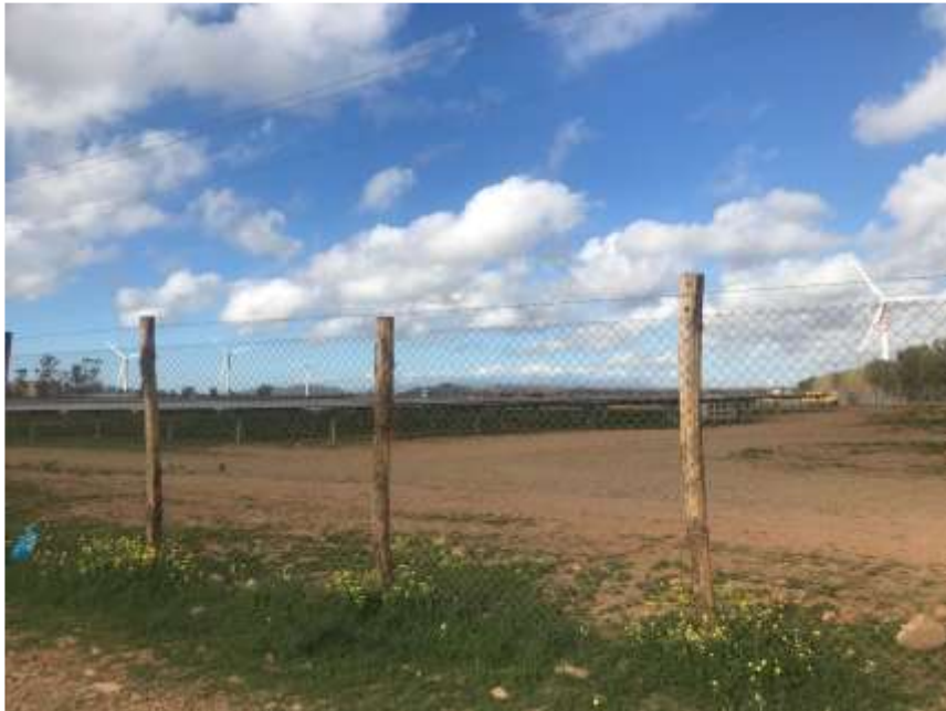
Figure 6-5 Tipologia di recinzione utilizzata
