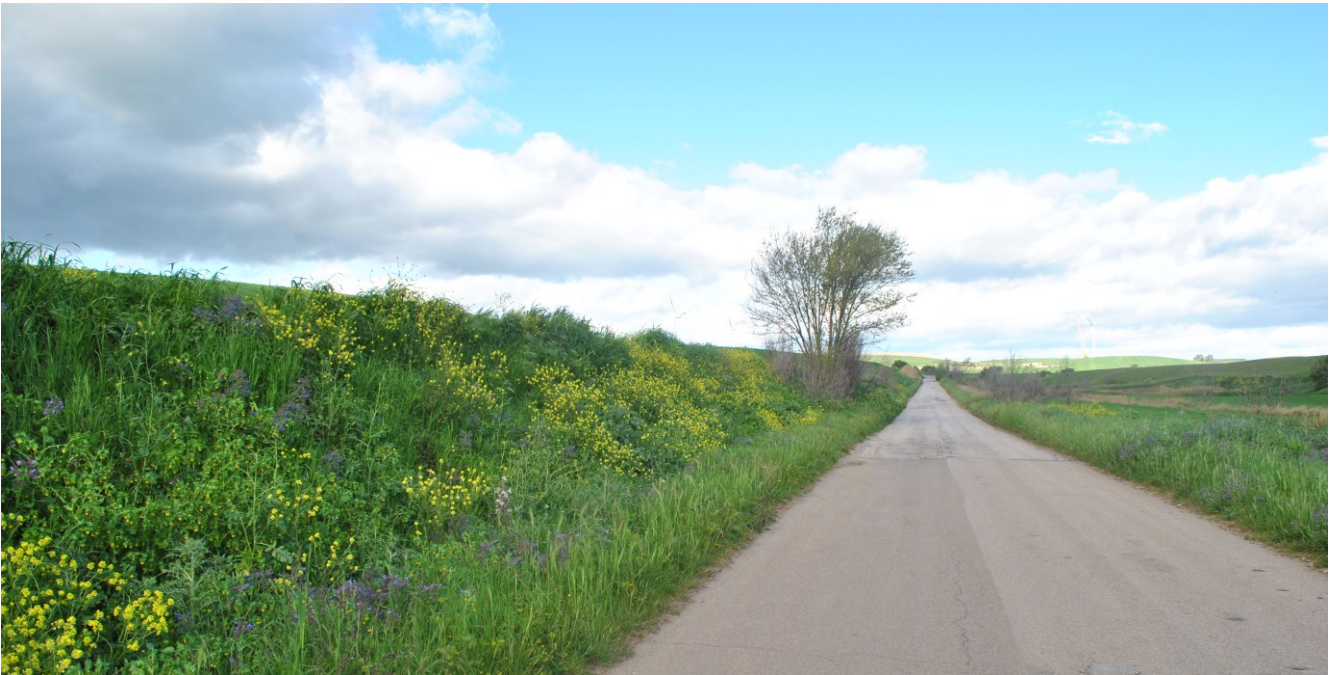
Figura 5 Punto di scatto n°4 SP 41b direzione Serracapriola .L'osservatore è posto in linea d'aria a circa 100 m dall'area d'intervento
