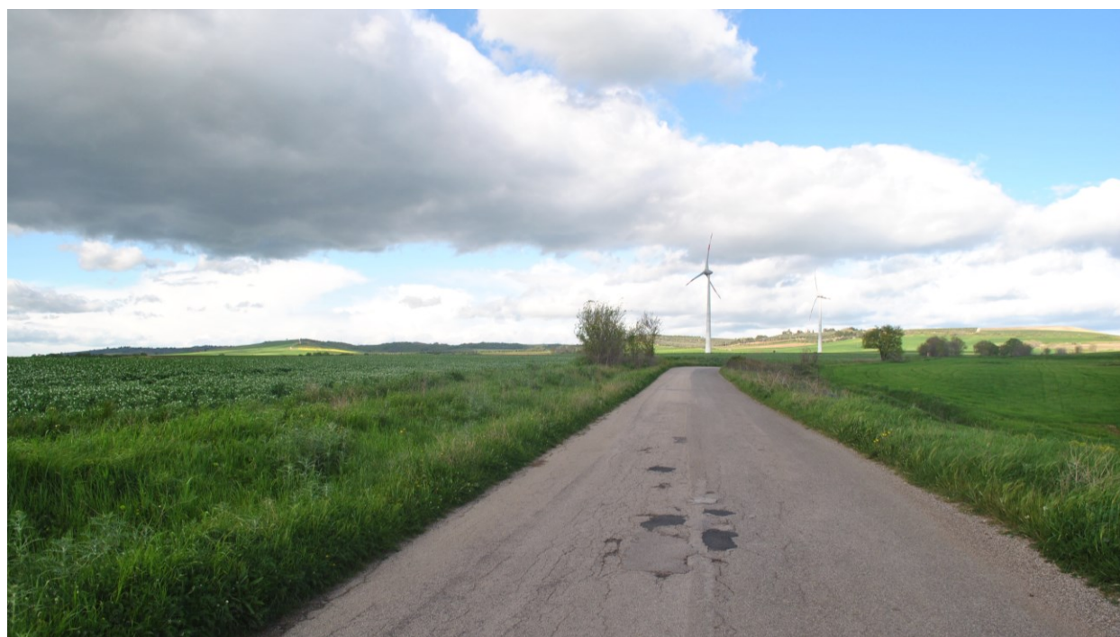
Figura 6 Punto di scatto n°6 SP 41b direzione Serracapriola .L'osservatore è posto in linea d'aria a circa 100 m dall'area d'intervento
