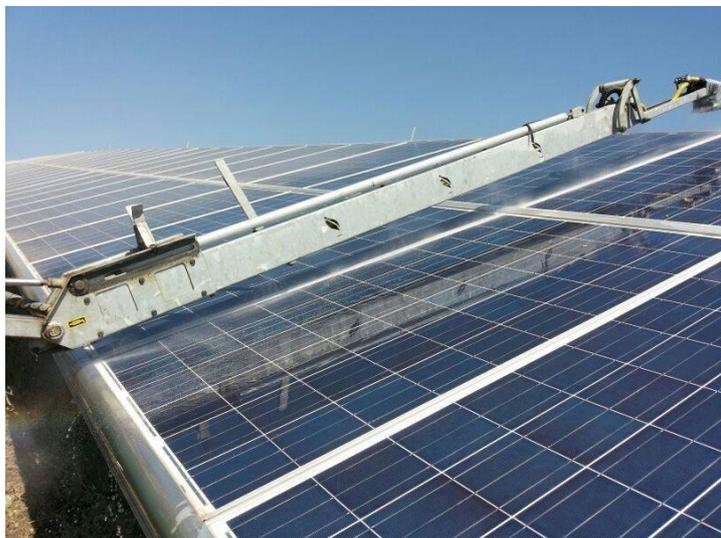
*Fig. 11 - Operazioni di pulizia moduli effettuate con sistema atomizzatore con uso esclusivo di acqua.*
