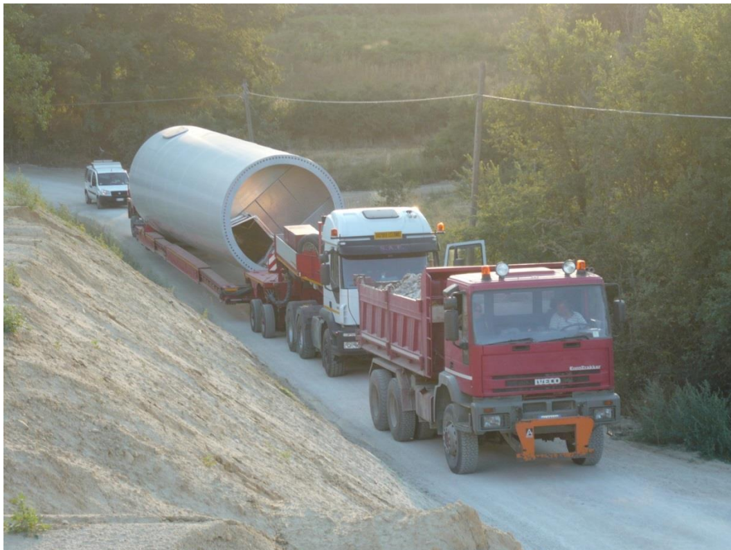
Figura 11. - Trasporto tramo su viabilità di sito/cantiere con mezzi modulari
